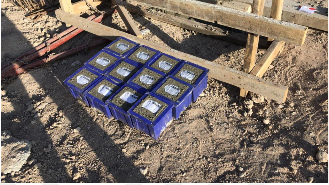
Şekil 1.15. Beton numunelerin alınması
