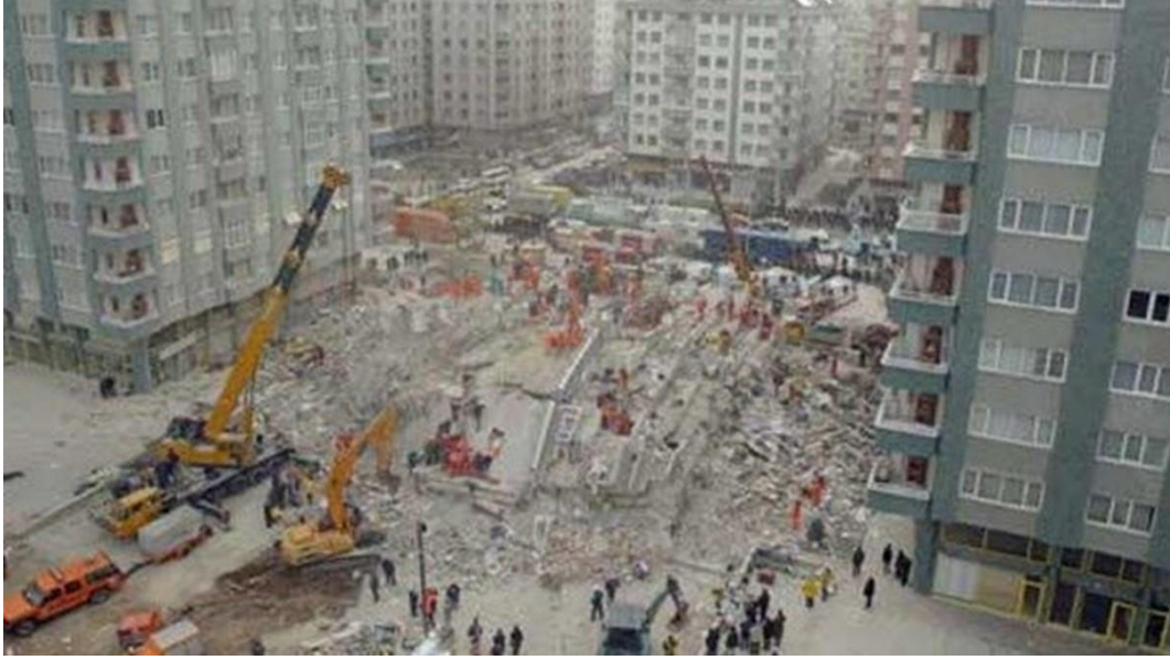
Şekil 1.8. Konya’da kendi ağırlığı ile yıkılan bir bina (Anonim, 2020b)
