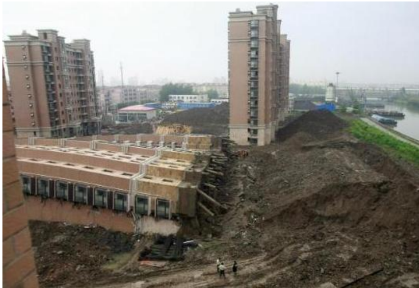
Şekil 1.20. Zemin sıvılaşması sonucu büyük hasara uğrayan bir bina (Anonim, 2020d)
