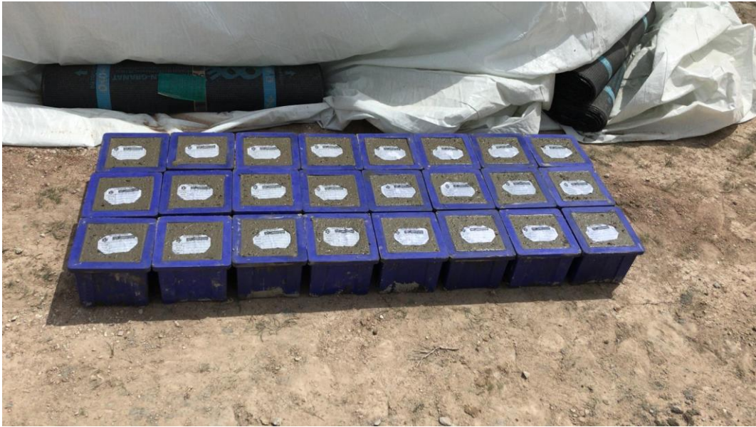
Şekil 1.14. Beton numunelerin alınması
