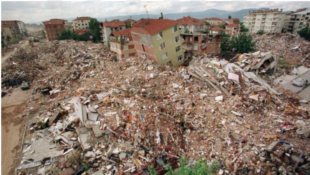
Şekil 1.6 1999 Gölçük depremi sonucu yıkıma uğramış bir çok bina (Anonim, 2019a)
