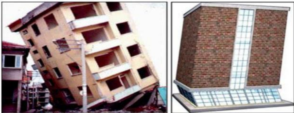
Şekil 1.12. Binada yumuşak kat düzensizliği (Anonim, 2019c)
