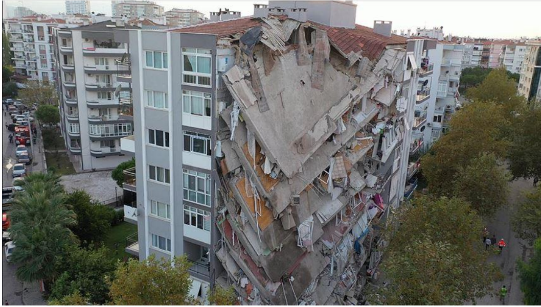
Şekil 1.25. 2020 İzmir depremi sonucu yıkılan bir bina (Anonim, 2020e)
