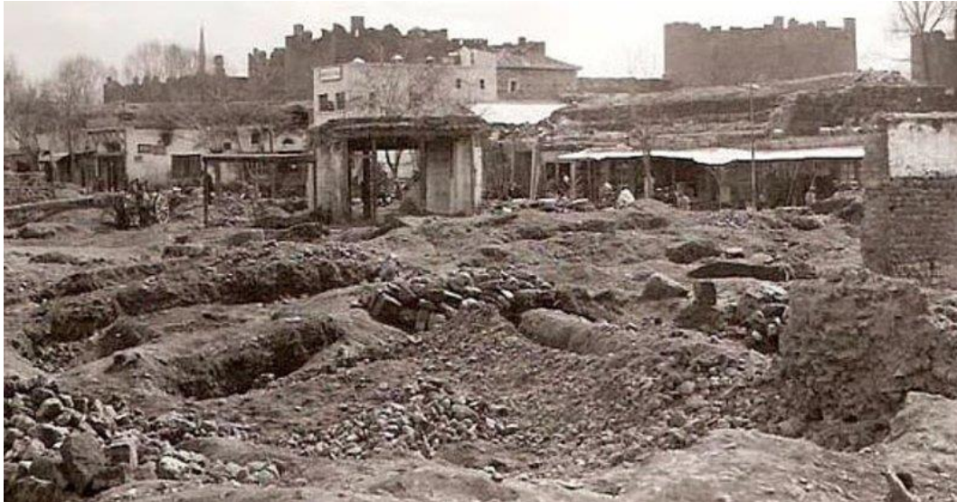
Şekil 1.7 1939 Erzincan depremi sonucu yıkıma uğramış bir çok bina (Anonim, 2019b)
