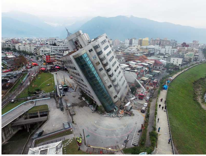
Şekil 1.19. Zemin sıvılaşması sonucu büyük hasara uğrayan bir bina (Anonim, 2020c)
