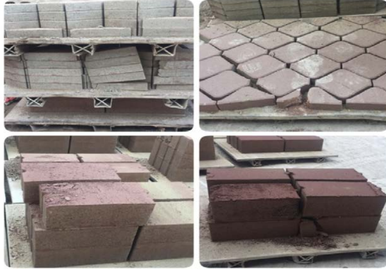
Şekil 3.2. İşlevini Yitirmiş (Atık) Prefabrik Beton Elemanlar
