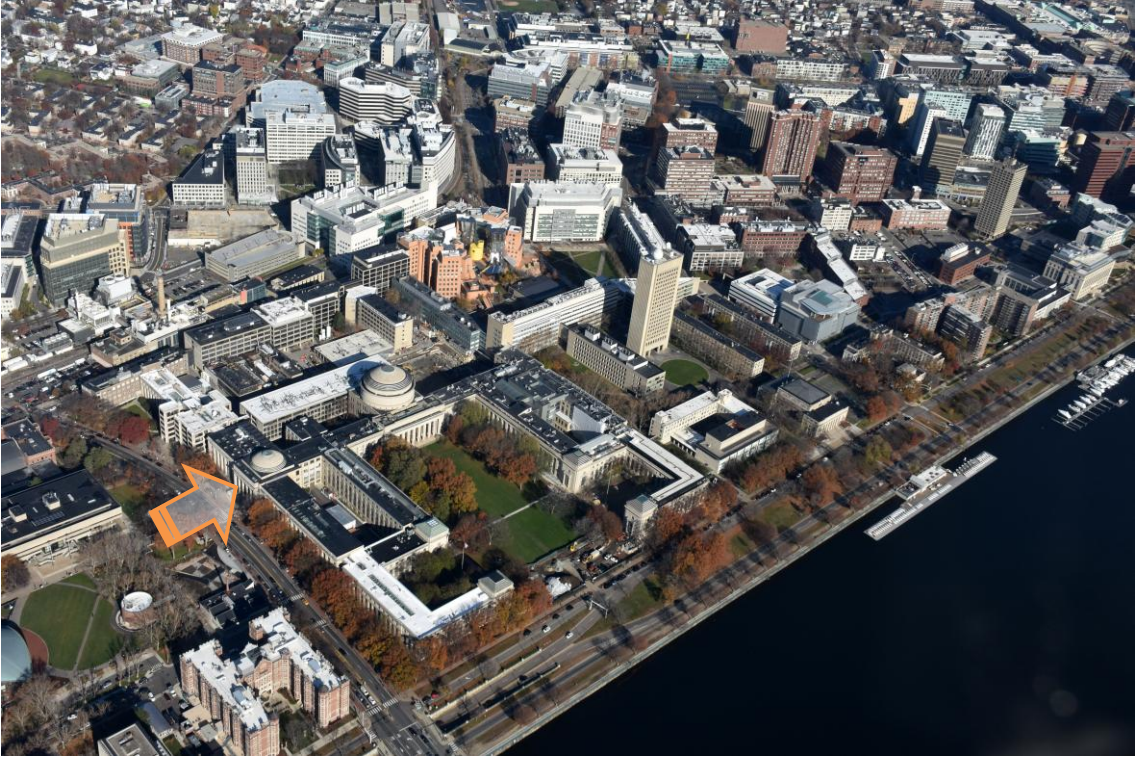
Şekil 3.14. Kampüsün ana girişi ve Rogers Binası
