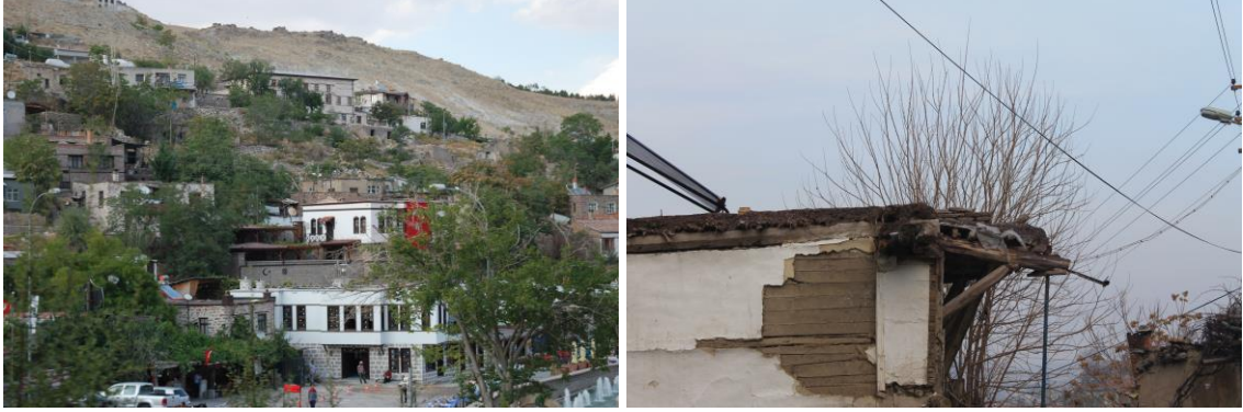
Şekil 31.Sille'de toprak dam ve çatılar (Orijinal, 2018).
