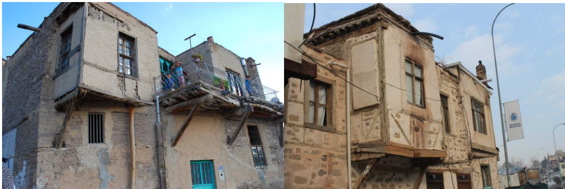
Şekil 34.Sille evinde çıkma ve balkon (Orijinal, 2018).
