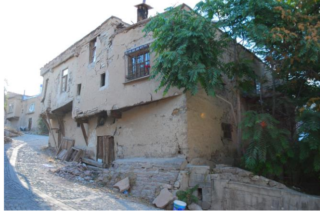
Şekil 29.Sille evi eğimli arazi ve bodrum kat kullanımı (Orijinal, 2018).
