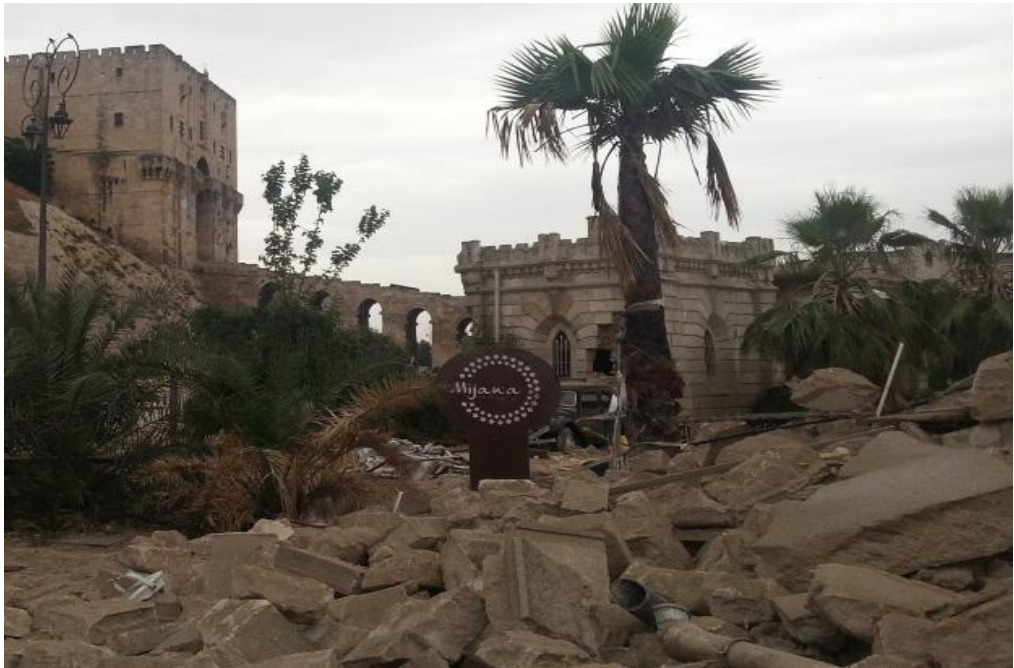
Şekil 63 Halep, Suriye Carlton otel'in Yıkımdan sonra Otel'i'nin 3.giriş yıkaması(jorjik orfilyan, 2015)
