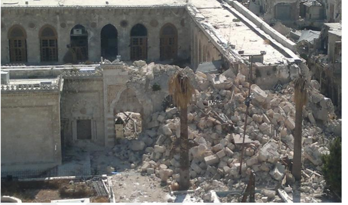
Şekil 76 Halep, Suriye Yıkım sonrası Emevi Camii'nin minaresi. (Halep Eski Eserler ve Müzeler Müdürlüğü, 2017)
