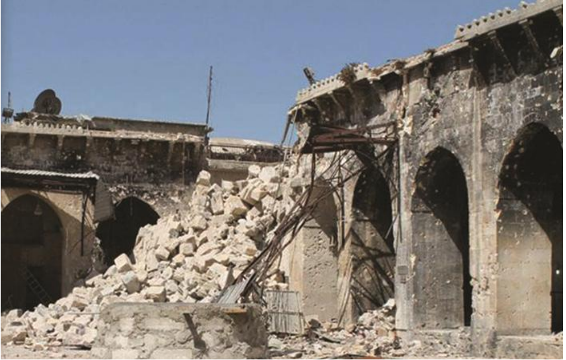
Şekil 79 Halep, Suriye Yıkım sonrası Emevi Camii'nin minaresi. (Halep Eski Eserler ve Müzeler Müdürlüğü, 2017)
