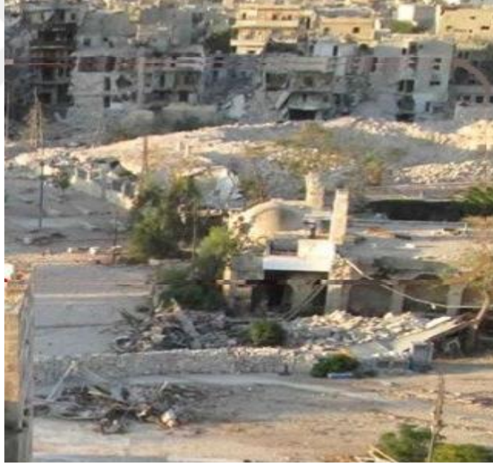
Şekil 36 Halep, Suriye Yıkımdan sonra Hüseyin Camii (Apsa Protect Syrian Heritage, 2011)
