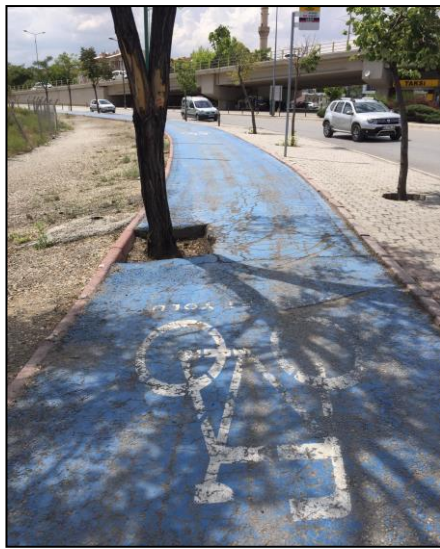
Şekil 4. 3 Bisiklet yolunda bulunan fiziksel engeller- Çevre Yolu cd. (Orijinal, 2019).
