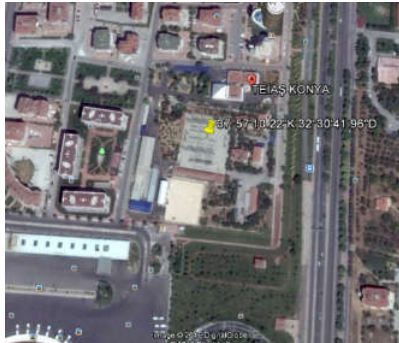
Şekil 9 (a) Ölçümleri yapılan trafonun Google Earth aracılığıyla elde edilen görünümü
