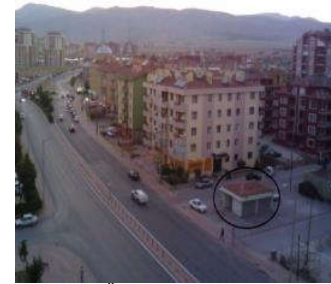
Şekil 8 (b) Ölçüm yapılan trafonun fotoğrafı
