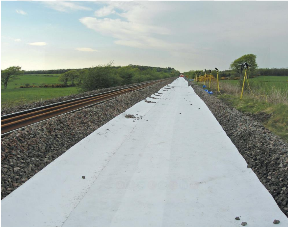
Şekil 3.63. Demiryollarında geotekstil kullanımı
