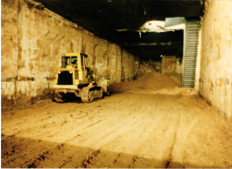
Şekil 3.69. Top-down metodu ile kazı yapılması
