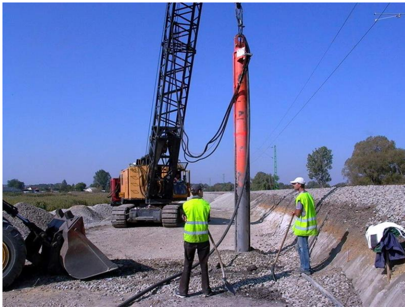
Şekil 3.53. Kuru üstten besleme uygulaması
