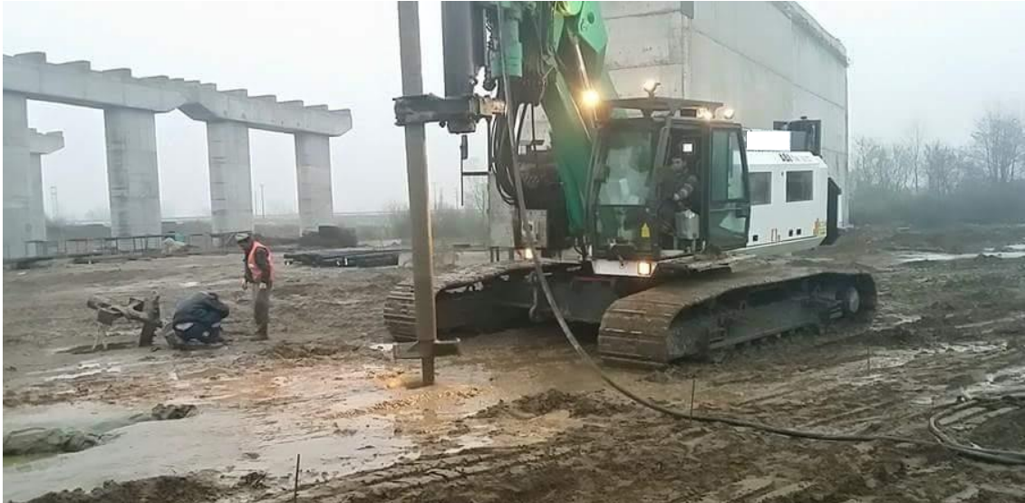
Şekil 3.49. Yaklaşım dolguları altında derin karıştırma kolonu uygulaması
