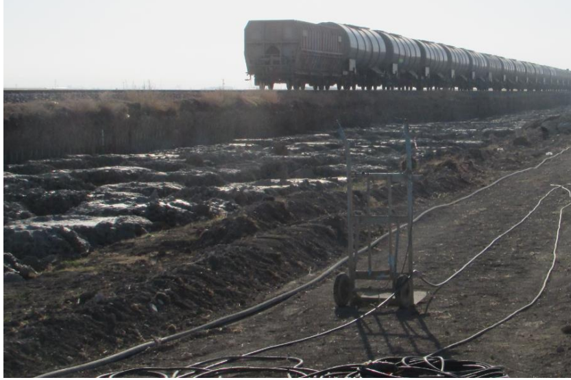
Şekil 3.50. Demiryolu hatlarında derin karıştırma uygulaması
