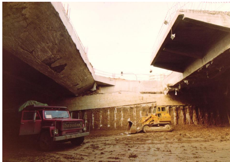
Şekil 3.67. Metro inşasında top-down kazı metodu
