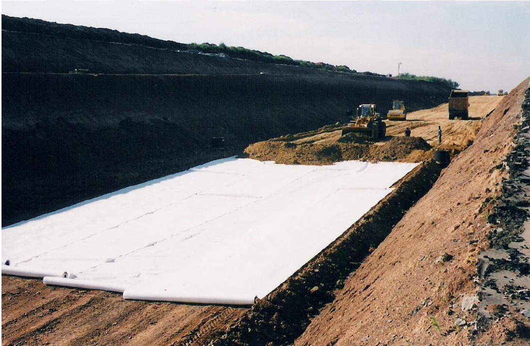
Şekil 3.65. Güzergâh dolgularında geogrid kullanımı
