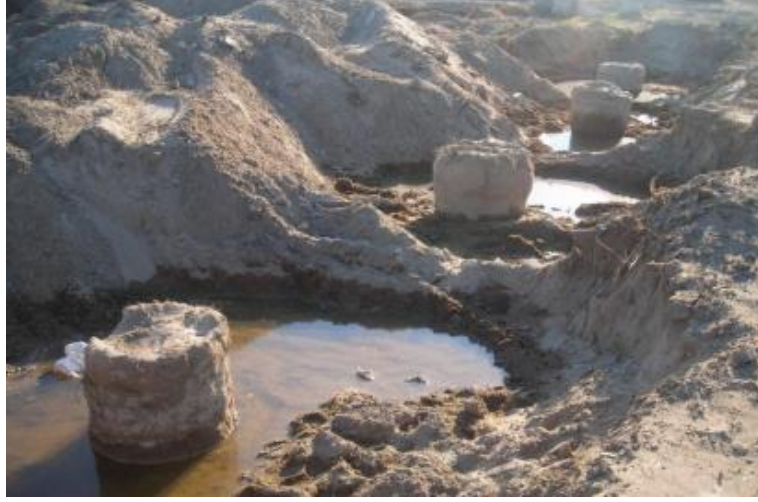
Şekil 3.59. İmal edilen Jet grout kolonları
