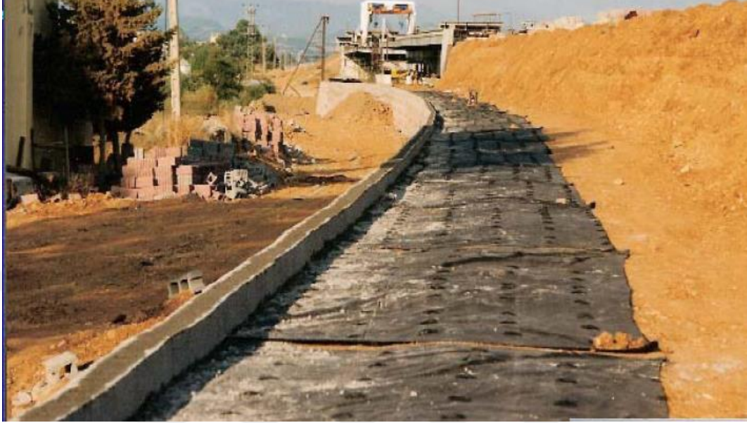
Şekil 3.64. Toprakarme duvar yapımında geogrid kullanımı
