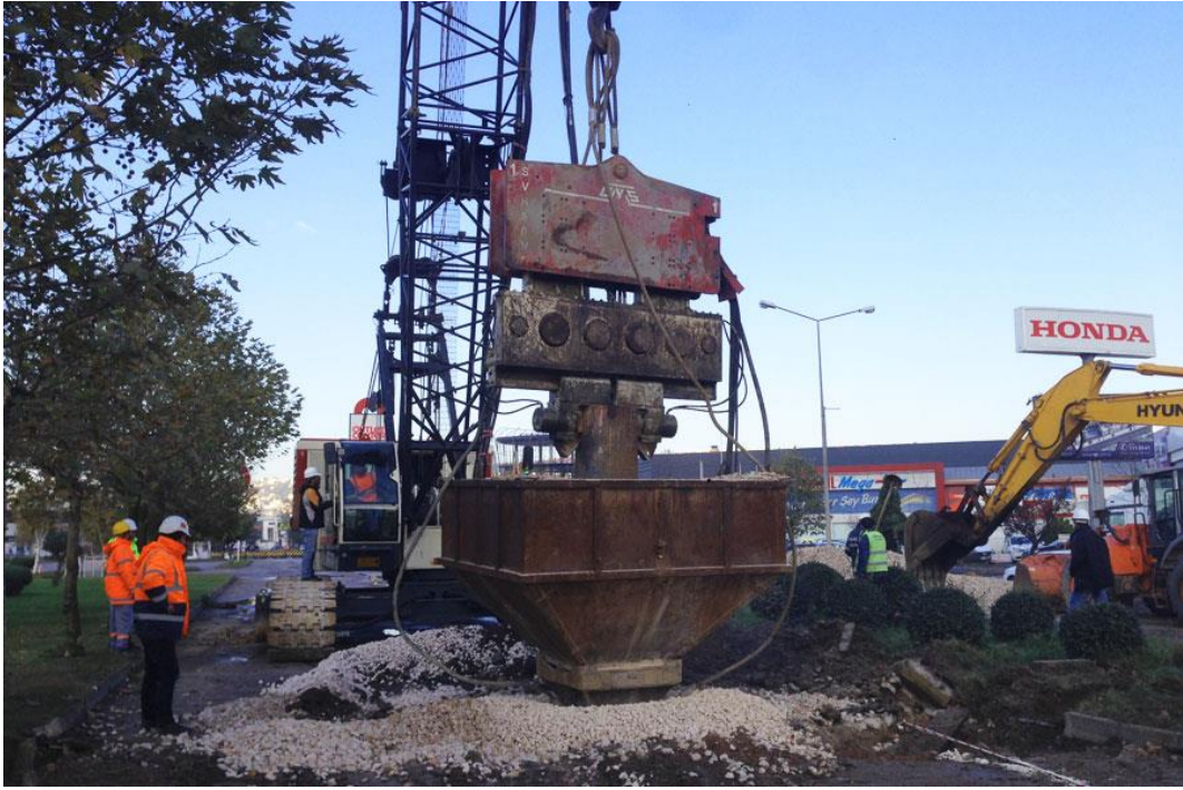
Şekil 3.54. Kuru alttan besleme uygulaması
