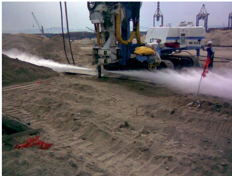
Şekil 3.58. Jet grout imalatı
