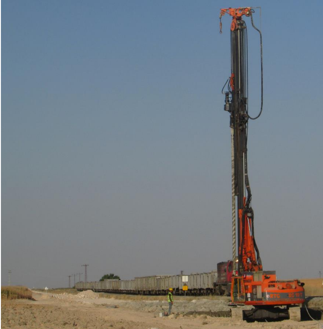
Şekil 3.51. Demiryolu hattı kenarında derin karıştırma kolonu imalatı
