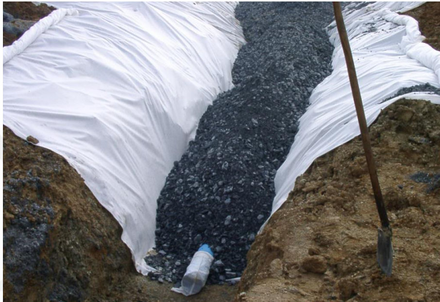
Şekil 3.66. Drenaj – filtre amaçlı geogrid kullanımı
