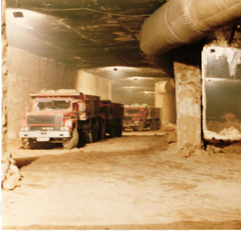
Şekil 3.68. Metro inşasında döşeme altında kazı yapılması
