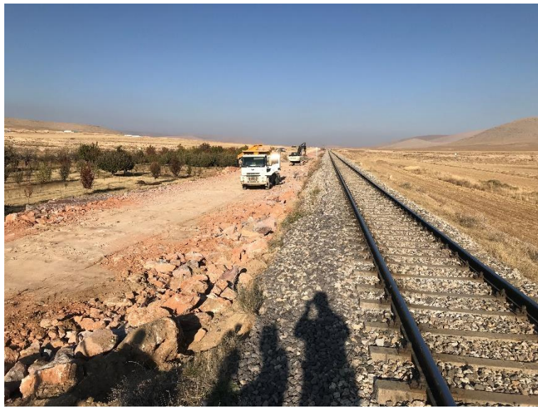
Şekil 3.60. Demiryolu hatlarında kaya dolgu uygulaması-1
