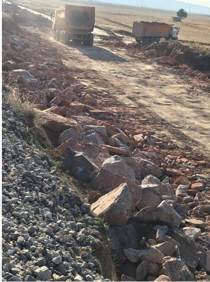
Şekil 3.61. Demiryolu hatlarında kaya dolgu uygulaması-2
