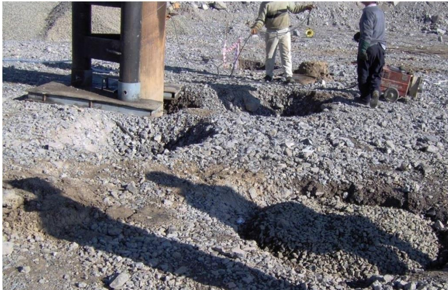
Şekil 3.52. Taş kolon uygulaması
