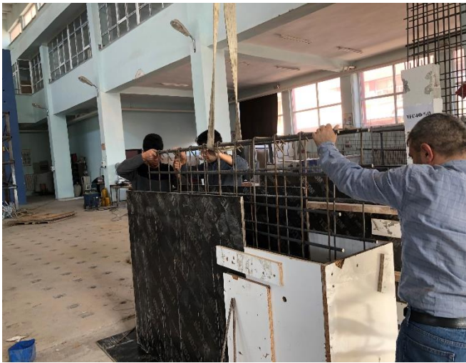
Şekil 1. Donatılı Karotların Alınması İçin Demirin Yerleştirilmesi.
