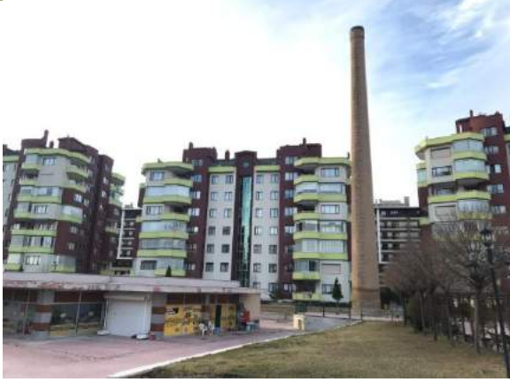
Şekil 22: Kiremit Fabrikası bacası
