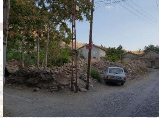
Resim 6. Yıkıldıktan Sonra Yapının Durumu
