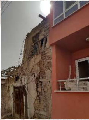
Resim 7. Yıkılmadan Önce Yapı (29556 Ada 2 Parsel)
