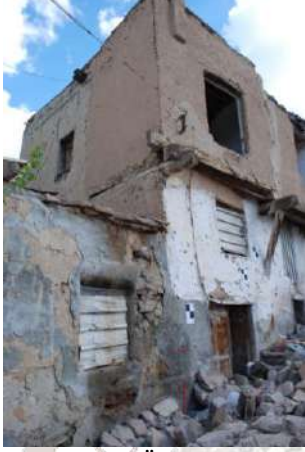
Resim 5. Yıkılmadan Önce Yapı (29560 Ada 21 Parsel)
