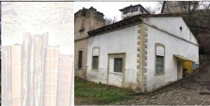
Şekil 8. Tabakhane Binası Sağ Cephe
