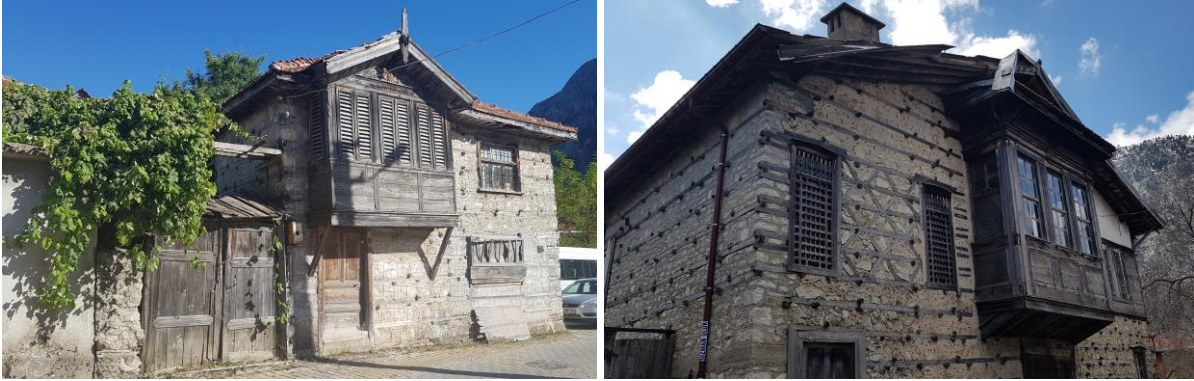
Şekil 3.7. Akseki/İbradı evleri (Korkmaz, 2018)
