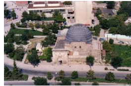
(Baloğlu Mimarlık Karatay Medresesi restorasyon raporu)
