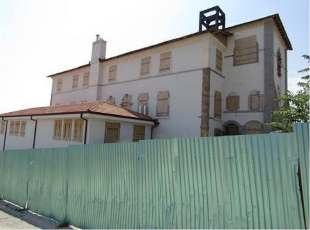
Şekil 6.46. Yapının kuzey cephesi
