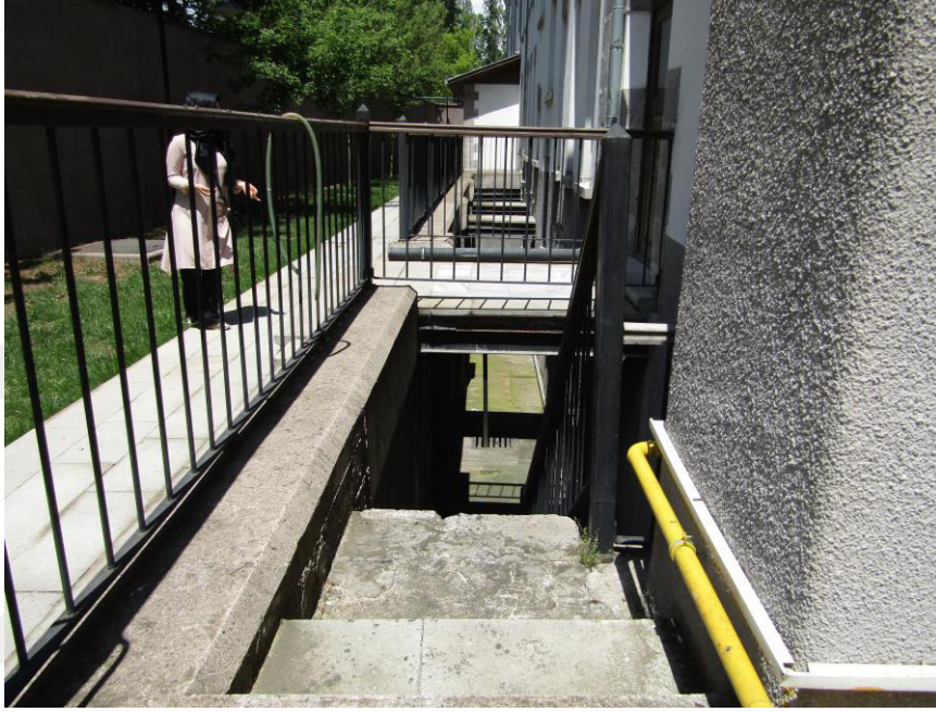
Şekil 6.90. Bodruma iniş merdiveni
