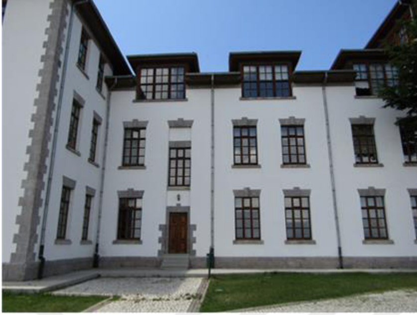
Şekil 6.82. Girişin batısında bulunan üç katlı blok
