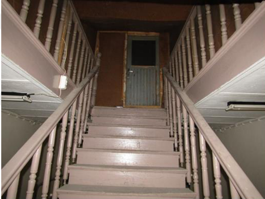
Şekil 6.129. Merdivenlerden çatı katına ulaşım
