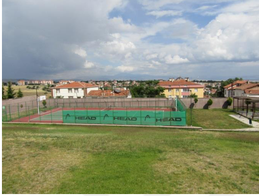
Şekil 6.92. Yapının bahçesinin mevcut durumu
