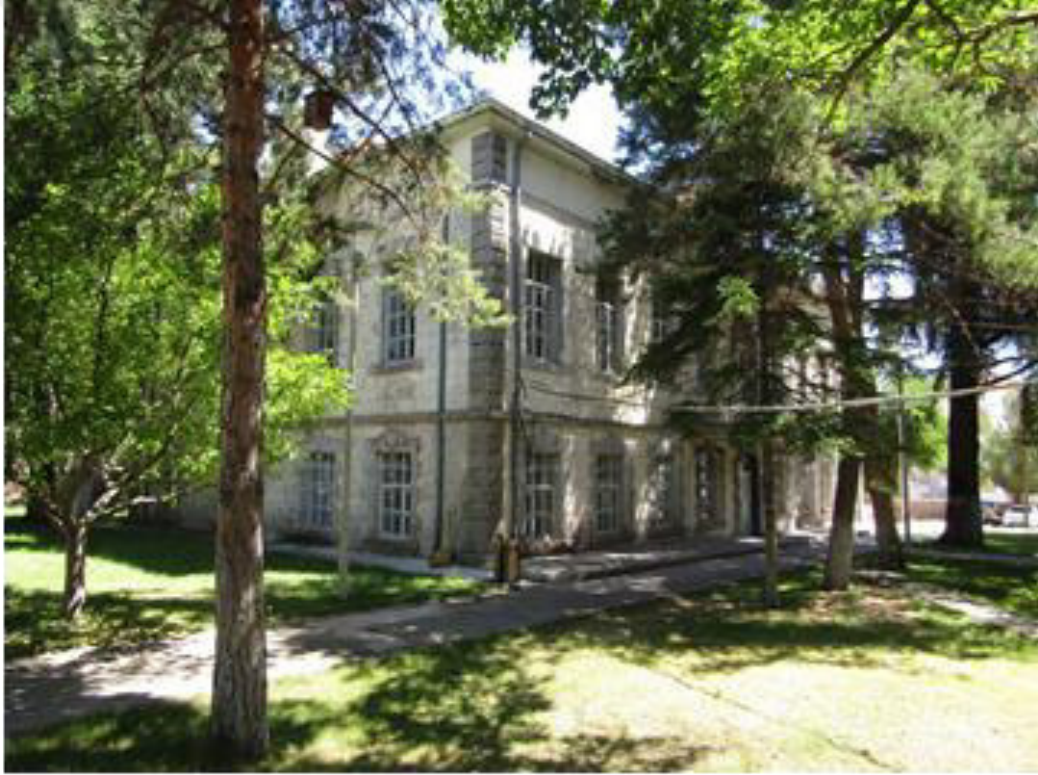
Şekil 6.103. Yapının mevcut durumu
