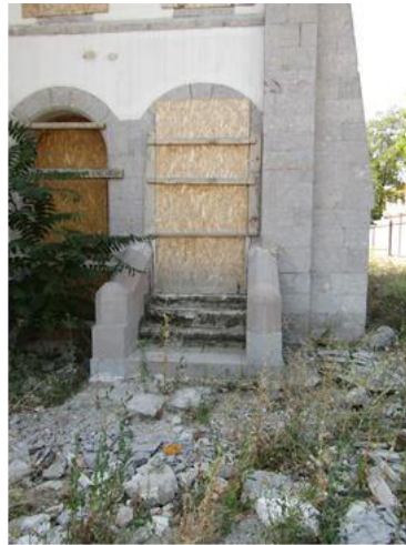
Şekil 6.30. Saat kulesi giriş merdivenleri
