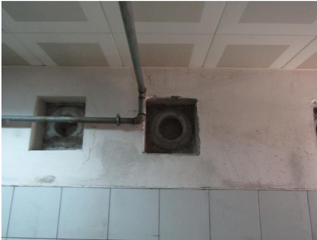
Şekil 6.59. Bodrum kattaki kalorifer sistem kalıntıları
