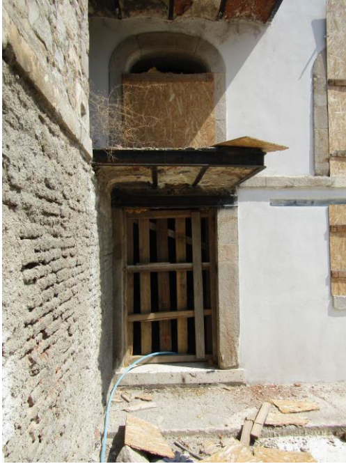
Şekil 6.16. Bodrum giriş kapısı (batı cephesi)
