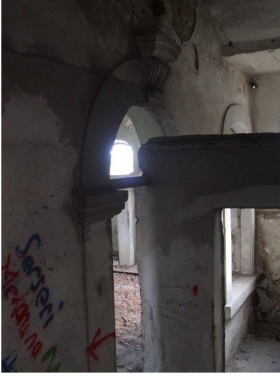
Şekil 6.33. Birinci kat kapı boşluğu (Fersah Mimarlık-Amasya)
