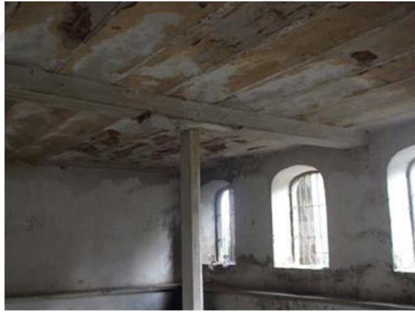
Şekil 6.23. Bodrum iç mekân (Fersah Mimarlık-Amasya) (restorasyon çalışmalarından önce)
