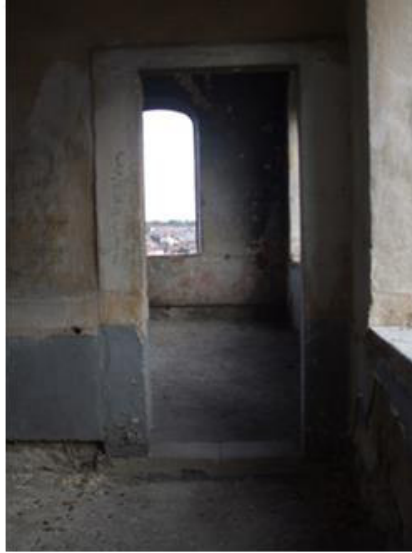
Şekil 6.37. Birinci katta mekânlar arasında geçişi sağlayan kapı boşluğu (Fersah Mimarlık-Amasya)
