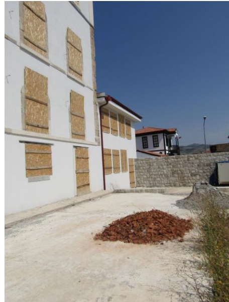
Şekil 6.26. Ana binadaki çamaşırhane ve muhdes binadaki çamaşırhane bölümü girişleri
