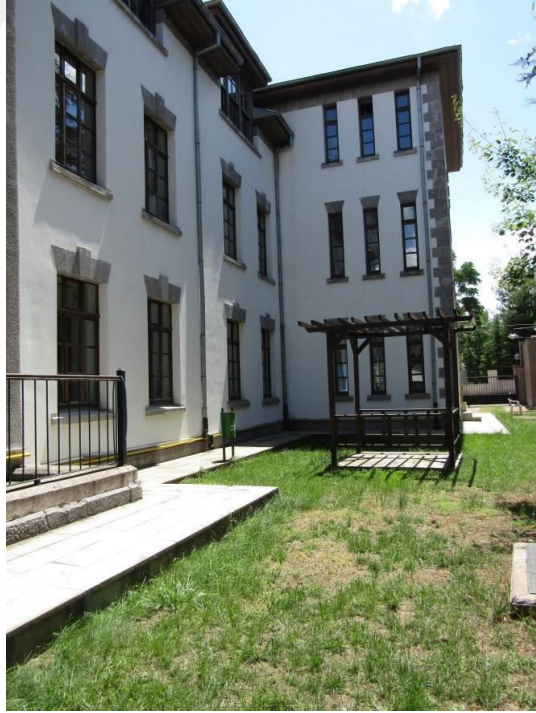
Şekil 6.86. Yapıya T olarak saplanan bölümün arka cepheden görünüşü
