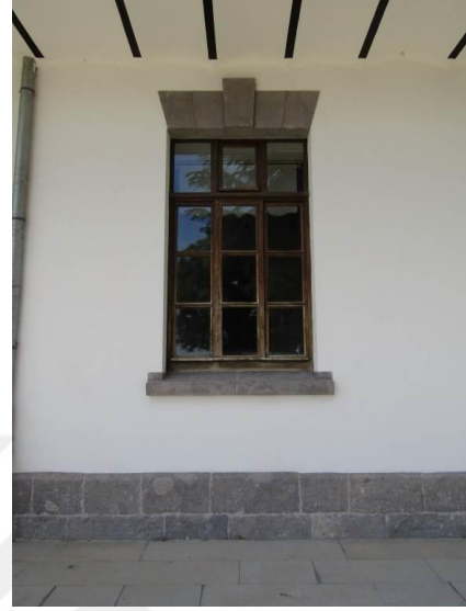
Şekil 6.72. Yapının her cephesinde yer alan pencere
