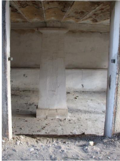
Şekil 6.20. Bodrumdaki odada yer alan taş kolon (Fersah Mimarlık-Amasya)
