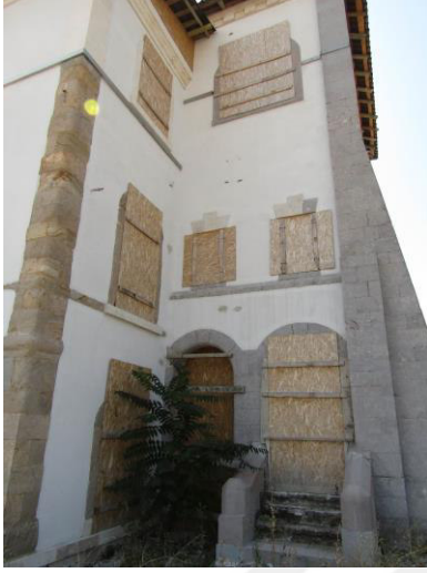
Şekil 6.28. Kuzey cepheden saat kulesine giriş
