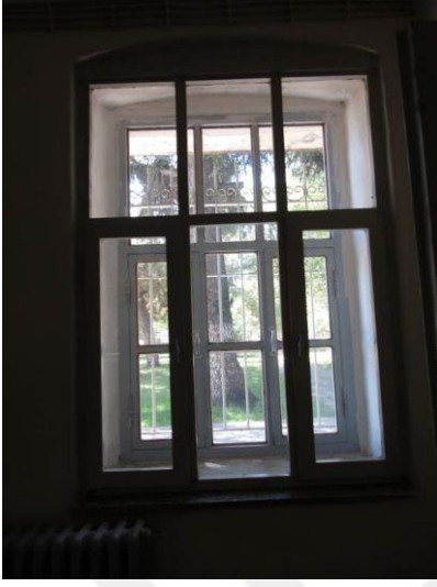
Şekil 6.119. Zemin kat pencere
