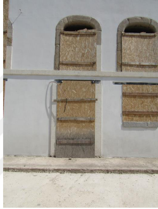
Şekil 6.17. Bodrum giriş kapısı (batı cephesi)
