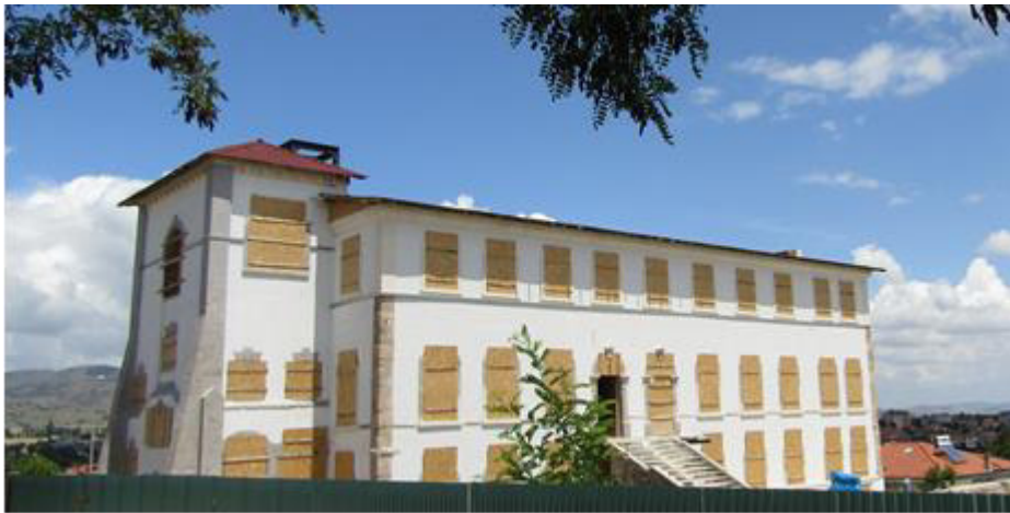
Şekil 6.43. Yapının güney cephesi
