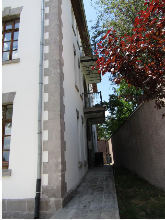
Şekil 6.81. Üç katlı blok, kuzeydoğu görünüşü
