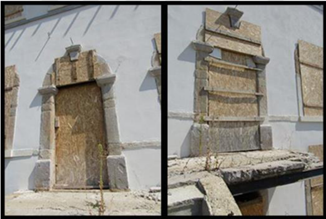
Şekil 6.45. Güney cephesinde yan yana yer alan giriş kapıları
