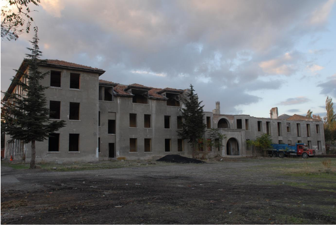
Şekil 6.54. Yapının restorasyondan önceki durumu (Yalçın Mimarlık-Amasya)
