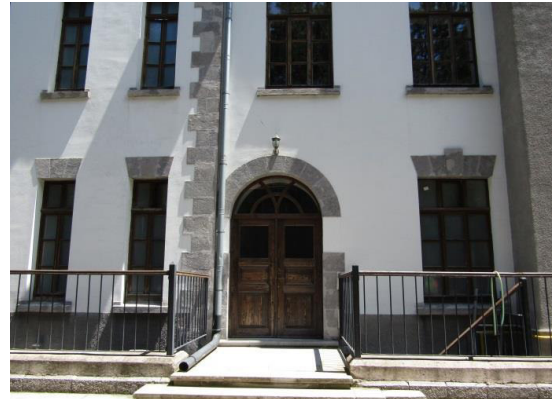
Şekil 6.63. Zemin kat arka cepheden giriş kapısı
