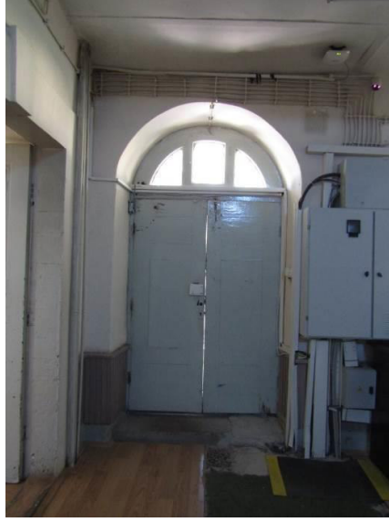
Şekil 6.106. Giriş kapısı içten görünüşü
