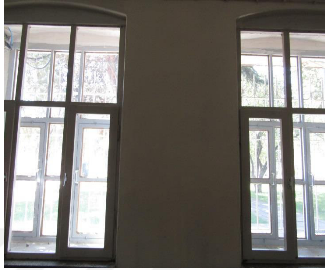
Şekil 6.120. Zemin kat pencere (iç ve dış pencereler)
