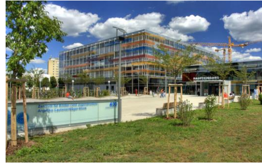
Şekil 3. Heidelberg Üniversite hastanesi Genel Görünüm [6]
