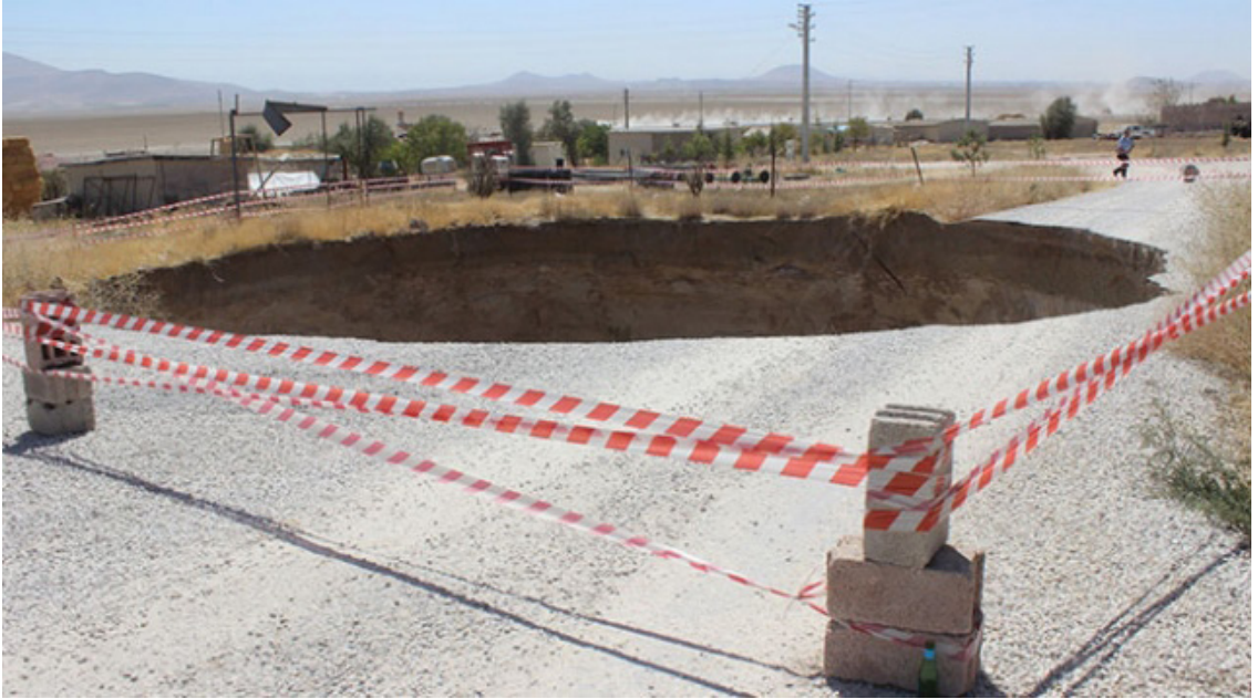
Şekil 6. Reşadiye Mahallesi Ekmekçi Yaylası yerleşim alanı içinde oluşan bir obruk (Karapınar-Konya)
