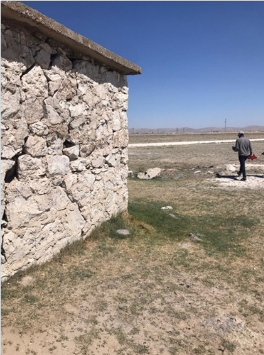
Şekil 69. Obruk belirtileri: Orta Anadolu'da bahçe duvarları ve yapılarda deformasyon (Arık vd., 2022)
