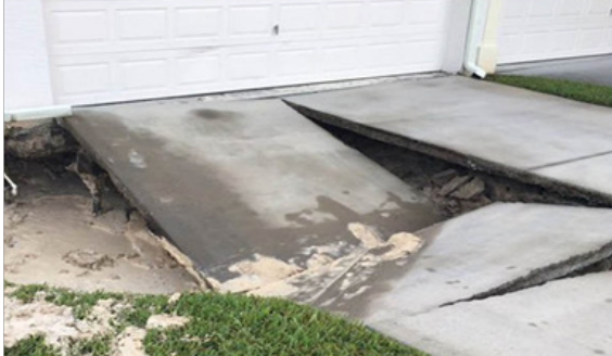
Döşemede Çökme Ve Kırılmalar
