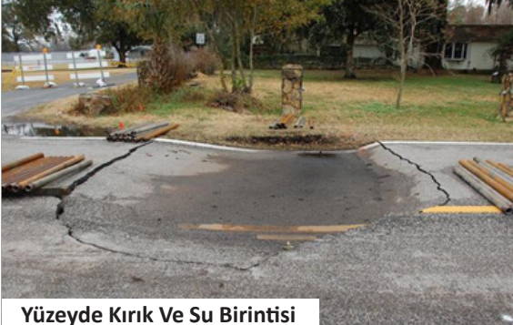
Döşemede Çökme Ve Kırılmalar
