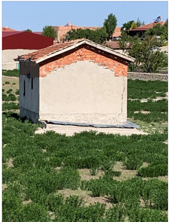
Şekil 69. Obruk belirtileri: Orta Anadolu'da bahçe duvarları ve yapılarda deformasyon (Arık vd., 2022)
