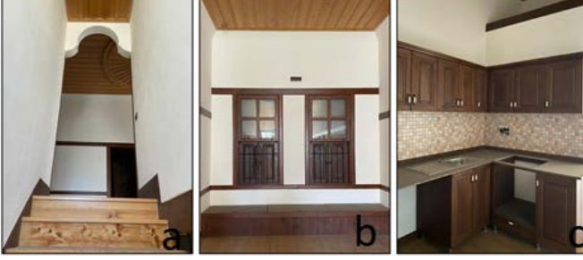
Şekil 19. Restorasyon sonrası zemin kat fotoğrafları; 19.a-Z06 no'lu merdiven; 19.b- Ü01 nolu sofada sedir; 21.c-Ü07 Mutfak fotoğrafı.
