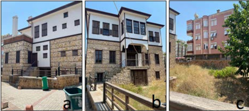
Şekil 23. Eray Erdem Evi restorasyon sonrasında cephe fotoğrafları, 26.a-Kuzey Cephe; 26.b- Güney Cephe; 26.c- Güney Bahçe fotoğrafları.
