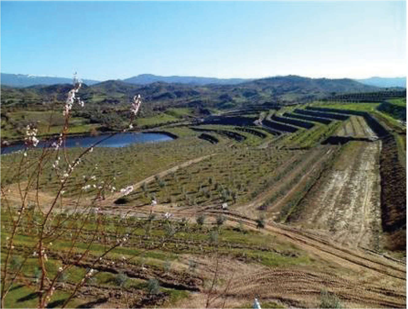
Şekil 6: Aydın’ın Efeler ilçesi Kuloğulları köyünde işletilen linyit ocağının iyileştirilmesiyle 13.000 ağaçlık zeytin ormanına dönüşümü (17).
