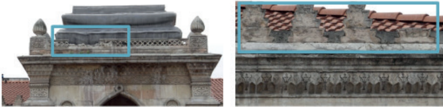
Şekil 9. Cephelerdeki Taş Kopmaları ve Aşınmaları (Mostar-a, 2017)
