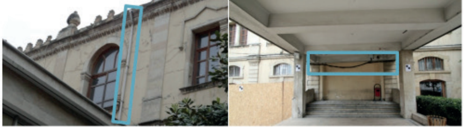
Şekil 13. Cephelerdeki Pvc Yağmur Oluğu ve Kablolar (Mostar-a, 2017)
