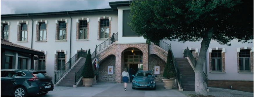
Şekil 2.2.1.4. Fabrika binasının girişinden bir görünüm.
