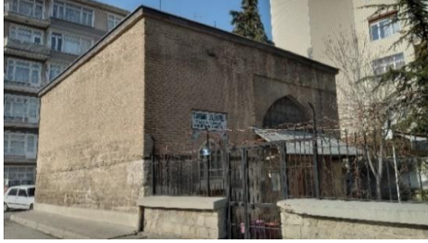
Şekil 6. Tahir ile Zühre Cami Güneydoğu cephesi (Kemerçi, 2023)
