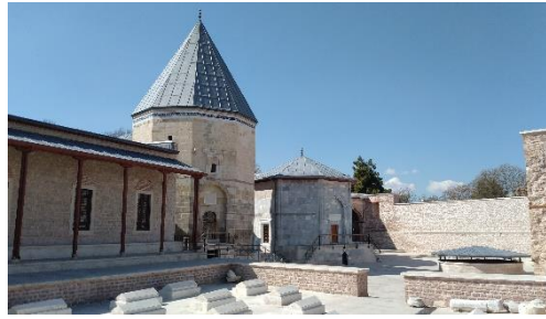
Şekil 36. Aleaddin Cami'nin kuzey bahçesindeki türbeler ve sarnıç (Kemerçi, 2023)
