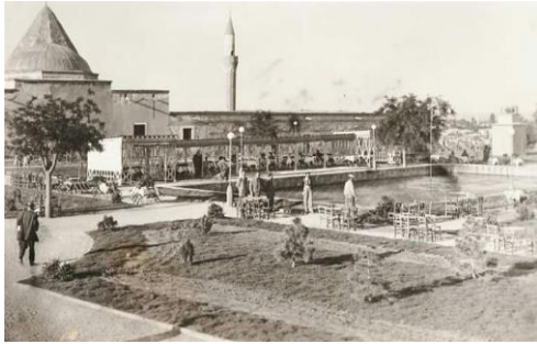
Şekil 39. Aleaddin Cami Güney cephesi ve çay bahçesi
