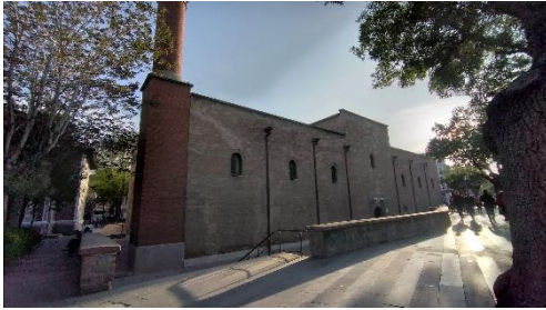
Şekil 45. İplikçi Cami Kuzeydoğu cephesi (Kemerci, 2023)
