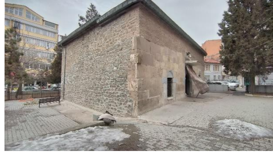
Şekil 27. Beyhekim Cami Güneydoğu cephesi günümüz (Kemerçi, 2023)
