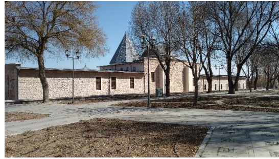
Şekil 40. Aleaddin Cami Güney cephesi ve bahçesi günümüz
