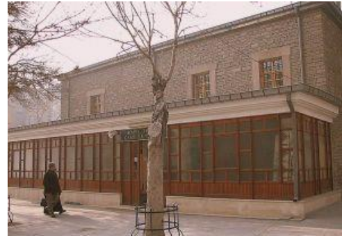
Şekil 55. Son onarım öncesi kuzeydoğu cephesi
