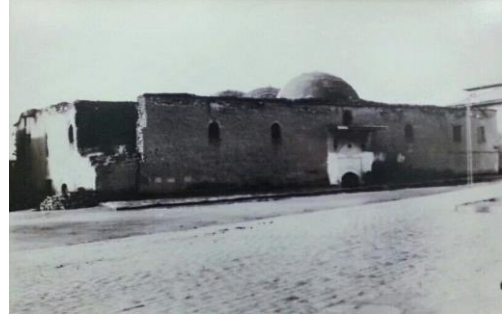
Şekil 48. İplikçi Cami'nin 1930'ta minaresinin yıkılmış durumu
