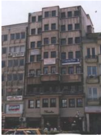
Resim 6. Apartman, Mithatpaşa Caddesi, İzmir.
