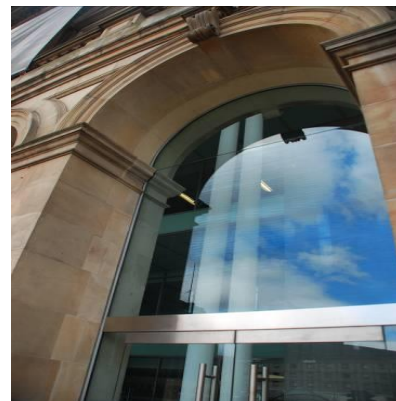
Resim 18. Edinburg Postane Binası Ön Cephe Kapı Açıklığı ve Strüktürü, İskoçya (Korumaz, 2010).
