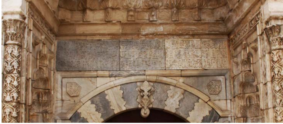
Görsel 8. Medrese Kitabesi ve Portal Detayları
