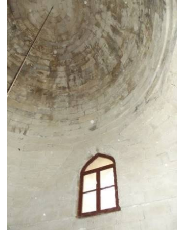
Görsel 20. Türbe Bölümü kubbesindeki Malzeme Renk Değişimleri
