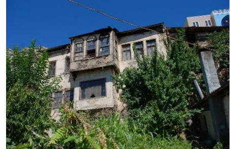
Şekil 9. Değirmenlik Mahallesi Konut, (2018)
