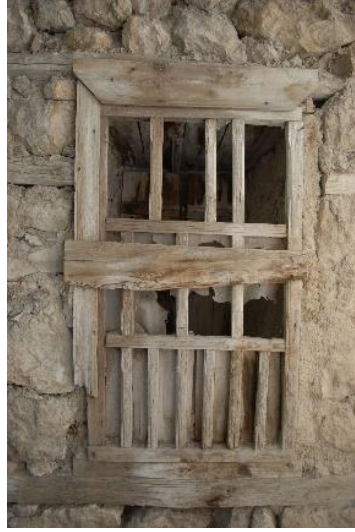
Şekil 11: Ahşap Pencere Kafesleri, Değirmenlik Mahallesi, 22 Parsel, (2018)
