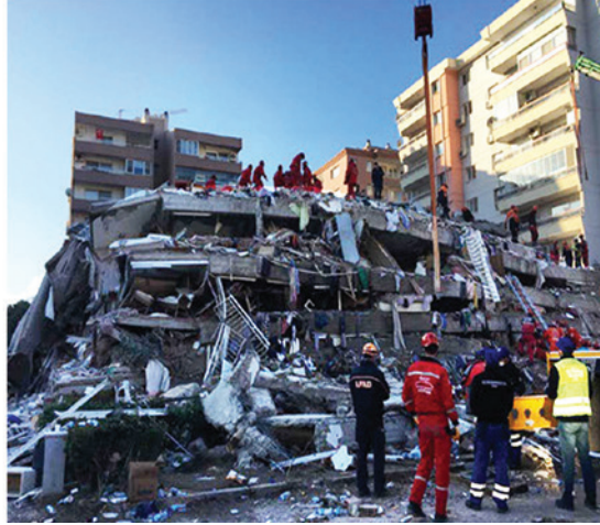
SOLDA İzmir depremi öncesi ve sonrası Rıza Bey Apartmanının durumu; GoogleMaps1 ve İTÜ,2020 (Resim 1)
