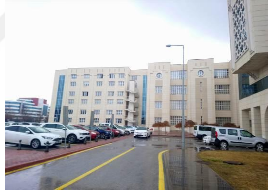
c- F Blok Güney Cephesi (Bakış Açısı-3)
