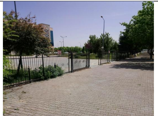
e- Adliye Güney Cephe Girişi (Bakış Açısı-5)
