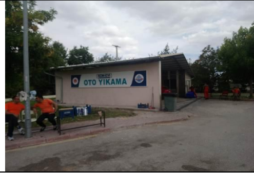
e- Yıkama Tesisi (Bakış Açısı-5)
