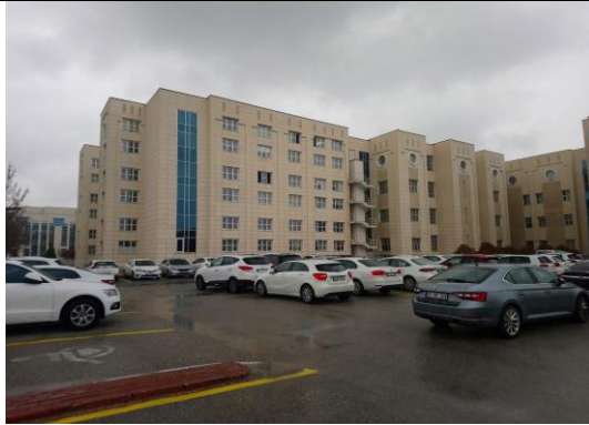
b- F Blok Güneybatı Cephesi (Bakış Açısı-2)
