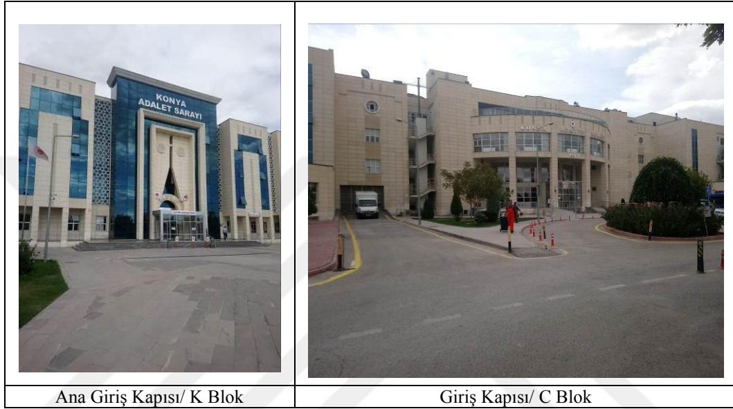
Şekil 5.3. Adliye Giriş Kapıları
