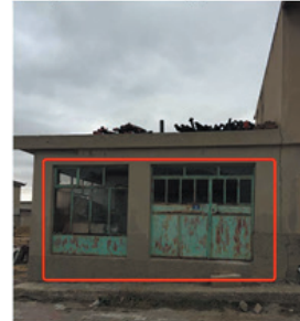
Kapı doğramalarının ahşap görünümlü alüminyum malzeme ile yenilenmesi
