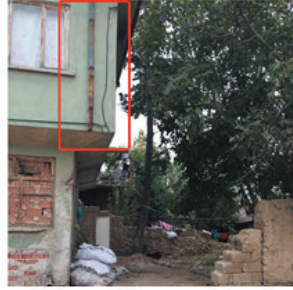
Yağmur oluklarının yenilenmesi
