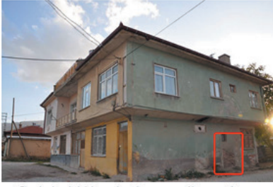
Cephelerdeki bozulmaların sıva ile onarılması
