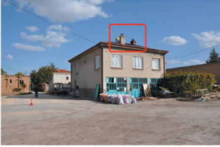
Bacaların onarılması ve temizlenmesi
