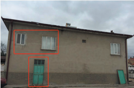
Pencere doğramalarının ahşap görünümlü pvc malzeme ile yenilenmesi
