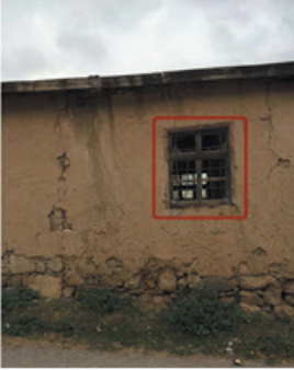
Pencere ve kapı doğramalarının ahşap malzeme ile yenilenmesi
