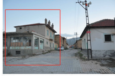
Çatısı olmayan yapıların marsilya tipi kiremit ile tamamlanması
