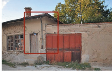
Yağmur oluklarının yenilenmesi
