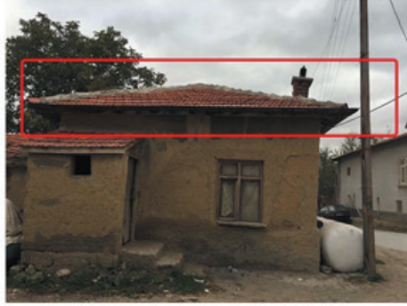
Çatıların alaturka tipi kiremit ile onarılması
