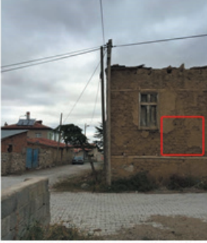
Cephelerin kerpiç sıva ile onarılması
