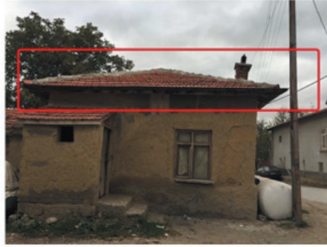
Çatıların alaturka tipi kiremit ile onarılması
