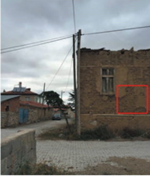
Cephelerin kerpiç sıva ile onarılması
