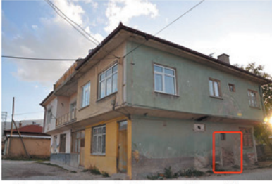
Cephelerdeki bozulmaların sıva ile onarılması
