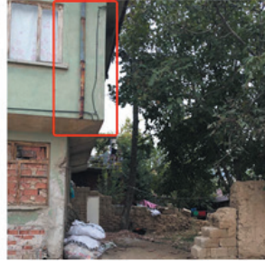
Yağmur oluklarının yenilenmesi
