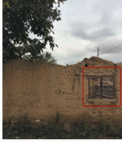
Korkulukların lokma demir pamaklık ile yenilenmesi
