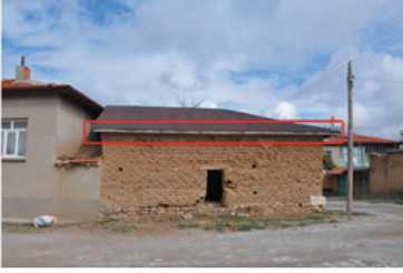
Çatı alınlıklarının yenilenmesi
