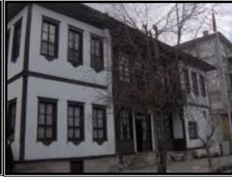
Fotoğraf.4.2.3 Nizamoğlu konağının güney cephesinden görünüşü
