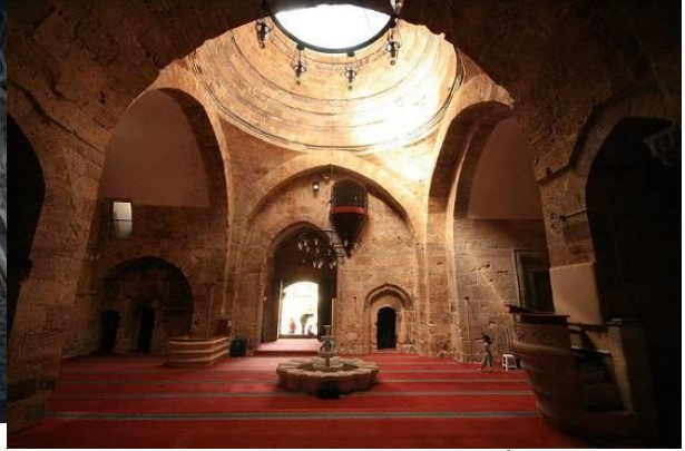
Kırşehir Cacabey Medresesi İç Avlu
