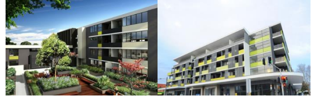
Şekil 1. Belle Evi genel görünüm [5]
