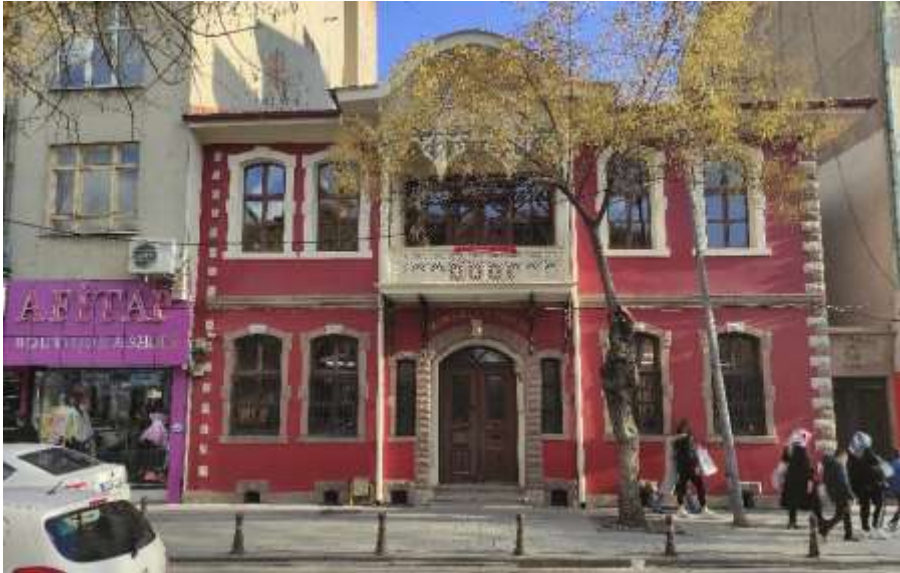
Figure 11. Mimarlar Odası / Dr. Nevzat Özkal House Facade (Dönmez, 2021)
