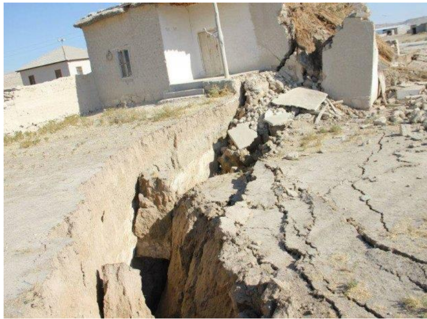
Şekil 4.7. Karapınar-Seyit Hacı Yaylasıobruğu ve zarara yol açtığı kerpiç ev
