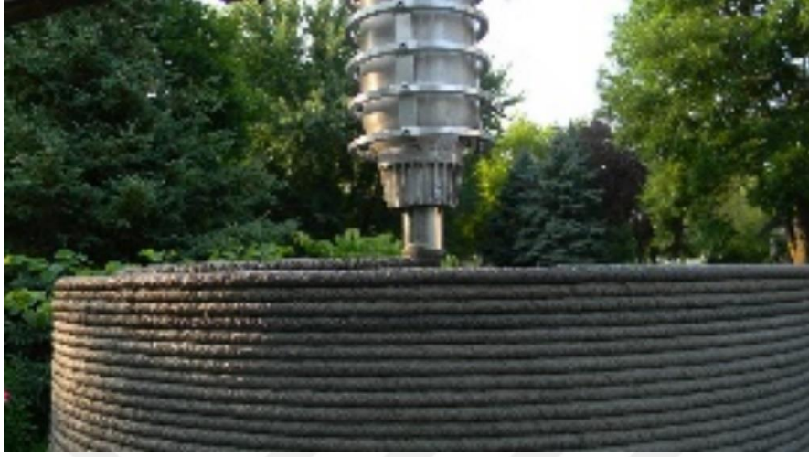
Şekil 1.4. Beton baskı işlemi (Anonymus, 2019)
