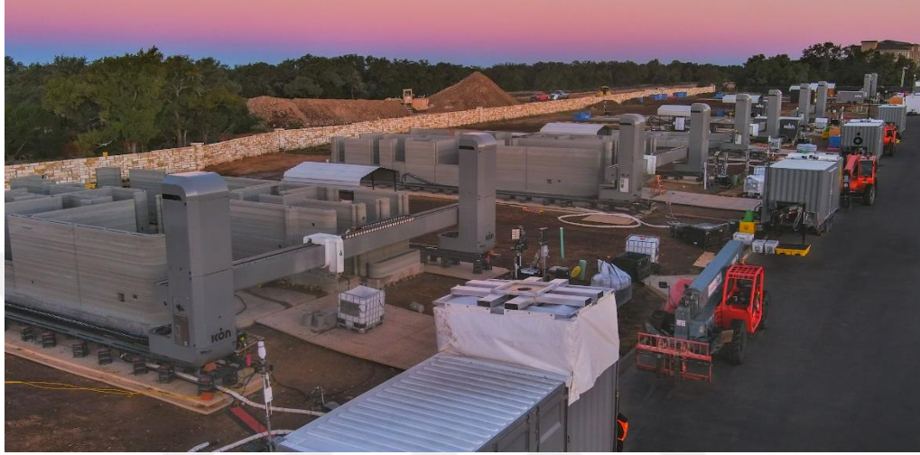
Şekil 1.6. ICON Vulcan inşaat sistemleri filosu, Genesis koleksiyonu için duvar sistemlerini basmaktadır (Bauguess, 2022)
