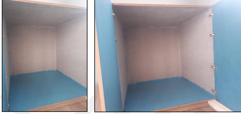
Şekil 3.89. Doğal ısı yalıtım sıvası öncesinde uygulanan astar
