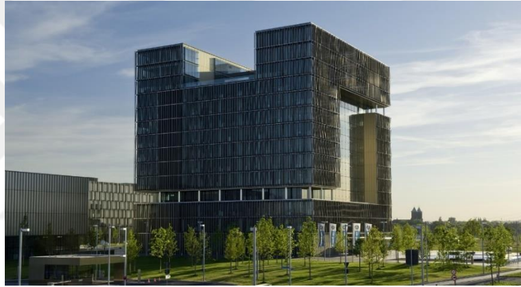
Şekil 2.45. Q1 Thyssen Krupp Genel Merkezi Görünüş (URL-27)
