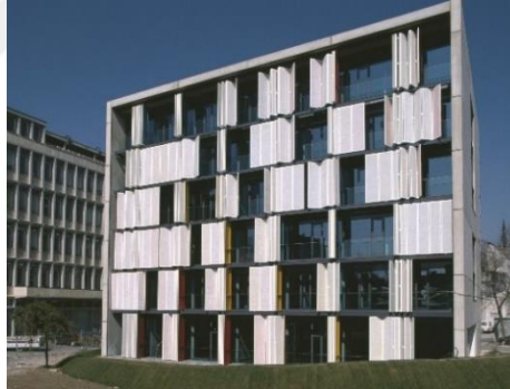
Şekil 2.43. Biyokataliz Laboratuvar Binası (URL-25).
