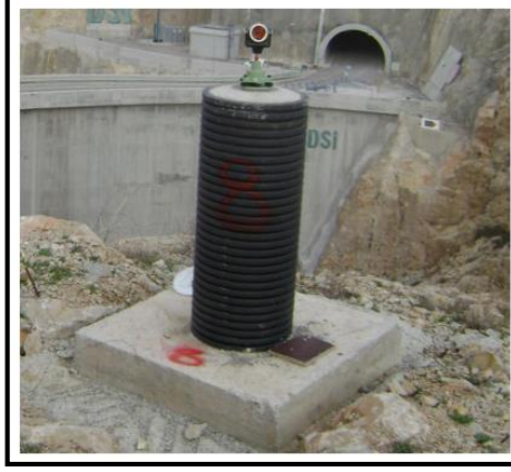
Şekil 2.3. Baraj Ölçmelerinde Pilye Örneği (İnal ve Bülbül, 2013)
