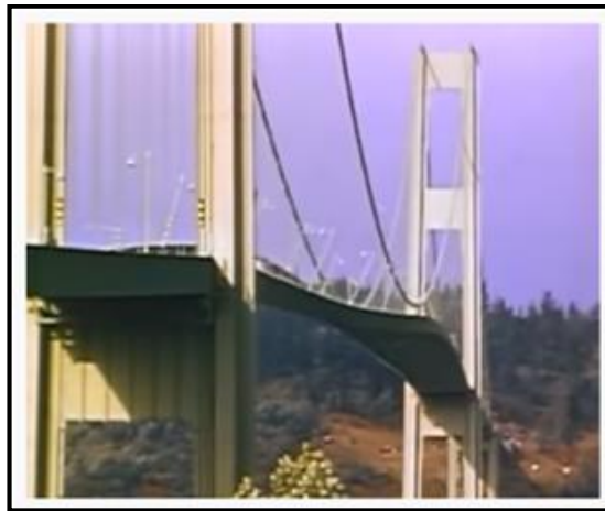
Şekil 2.7. ABD’de yeni yapılmış olan Tacoma Narrows köprüsünün rüzgârın etkisi ile salınımı (Url.3).
