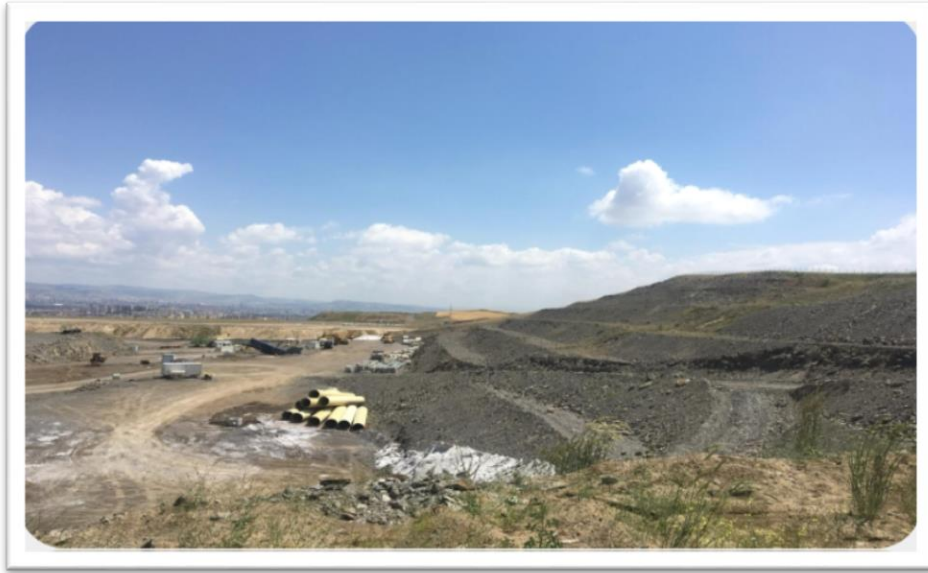
Şekil 7. Etimesgut Bazalt Ocağı
