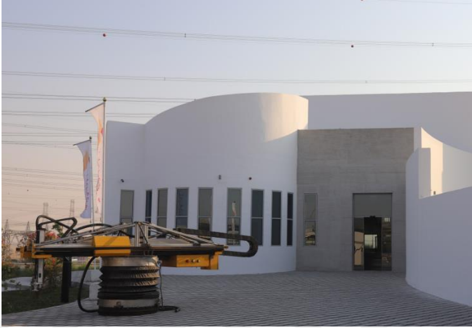
Şekil 2.2. 3D yazıcılar kullanarak 640 metrekarelik ve 9,5 metre yüksekliğinde inşa edilen bina ( https://www.webtekno.com )
