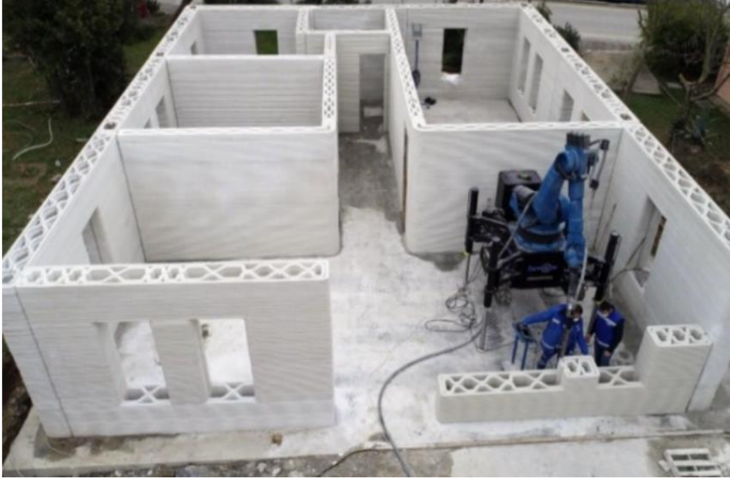
Şekil 3.2. 3D beton teknolojisi ile imalatı yapılan örnek bir bina görseli (İndigo dergisi, İSTON, 2021)
