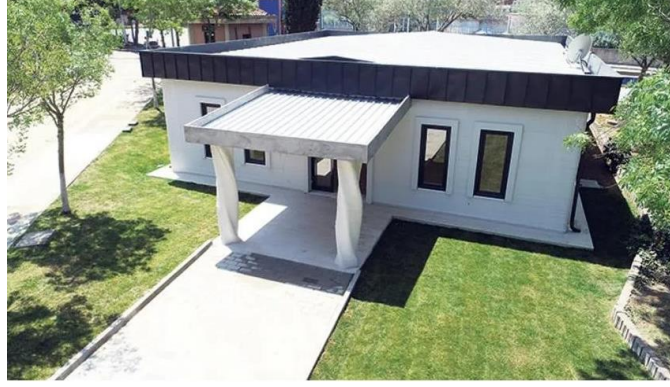
Şekil 3.7. İSTON firması tarafından 3D yazıcı beton ile imalatı tamamlanan binanın görseli (URL 30)
