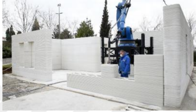
Şekil 3.8. İSTON firması tarafından 3d beton yazıcı ile imalatı tamamlanan binanın görseli (URL 30)
