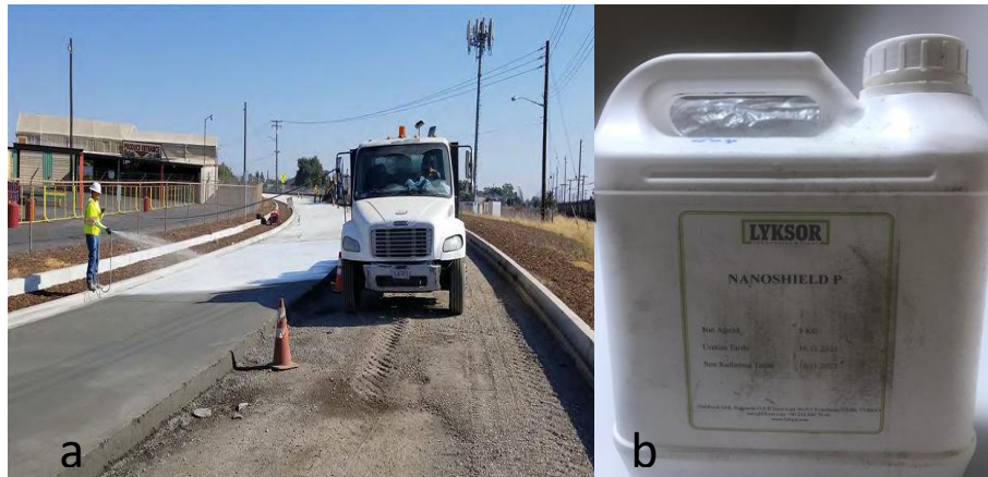
Şekil 3.5. SSB kür işlemi a)Saha uygulaması kaynak b)Kullanılan kür malzemesi
