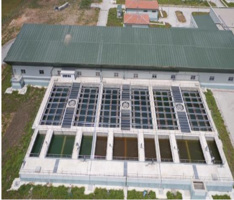
Şekil 3.8. Mavi Tünel İçme Suyu Arıtma Tesisi Yavaş Karıştırıcı ve Durultucu Yapısı
