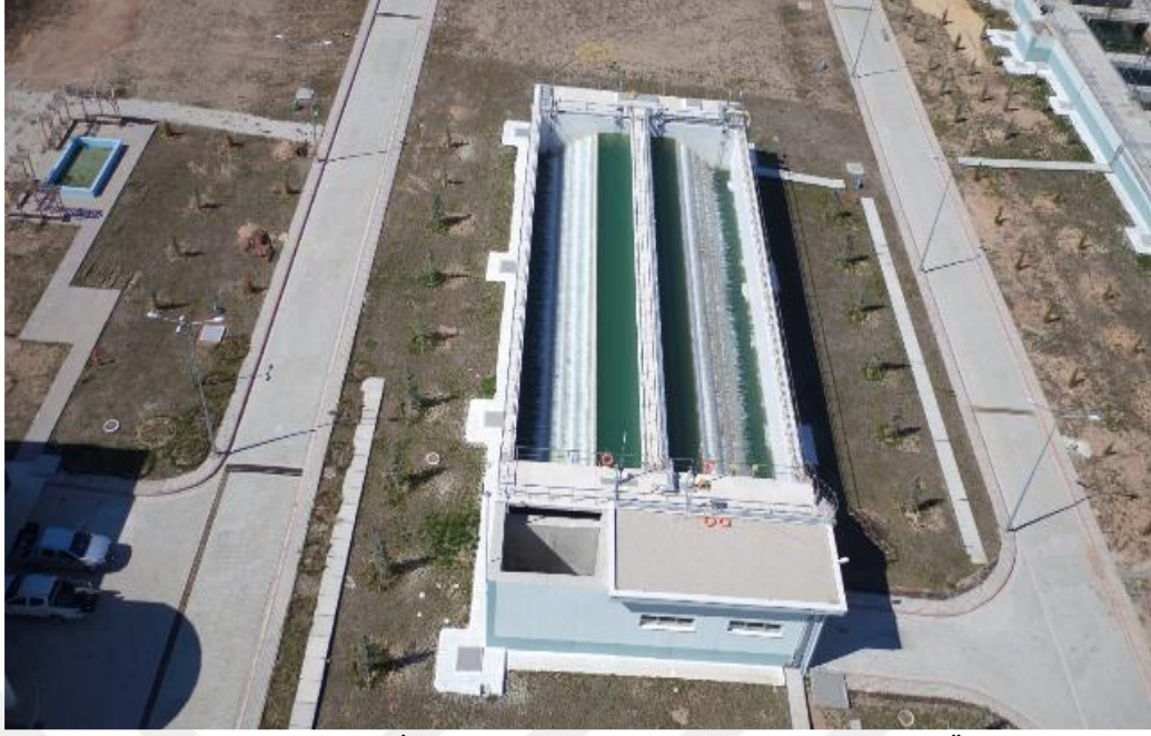
Şekil 3.5. Mavi Tünel İçme Suyu Arıtma Tesisi Giriş Havalandırma Ünitesi
