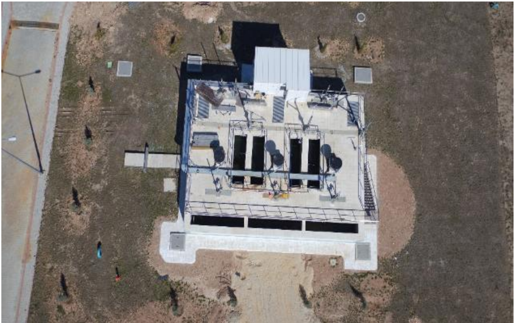
Şekil 3.6. Mavi Tünel İçme Suyu Arıtma Tesisi Hızlı Karıştırıcı Ünitesi
