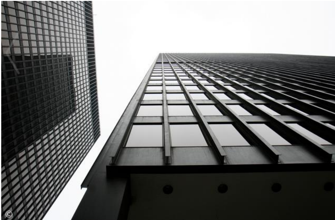
Şekil 3.20. Seagram Binasının Cephesindeki I Kirişler (URL 28)
