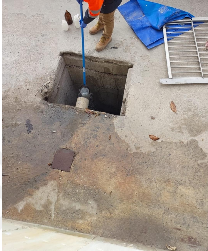
Şekil 3.8. Numune çubuğuyla numunelerin alınması
