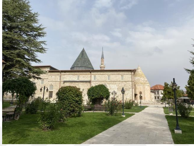
Şekil 4.17. Eşrefoğlu Cami Güney Cephesi (2022)
