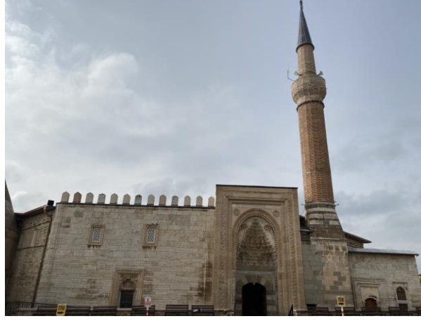
Şekil 4.14. Eşrefoğlu Cami kuzeydoğu cephesi (2022)
