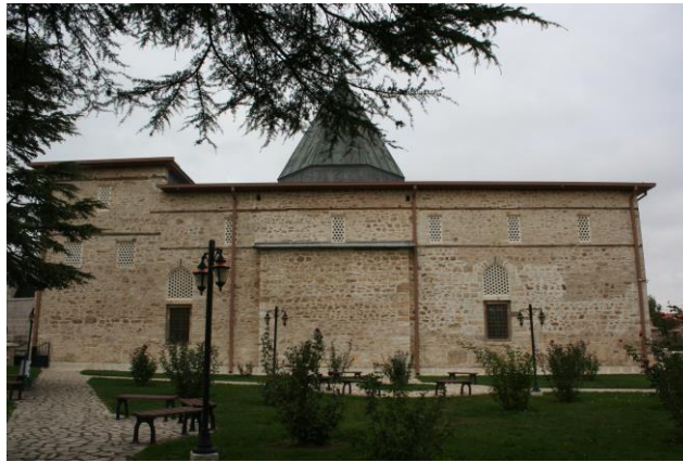
Şekil 4.18. Eşrefoğlu Cami Güney Cephesi (2022)
