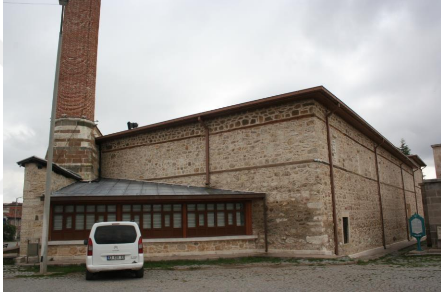
Şekil 4.22. Eşrefoğlu Cami kuzey cephesi ve sonradan kapatılan kütüphane bölümü (2022)
