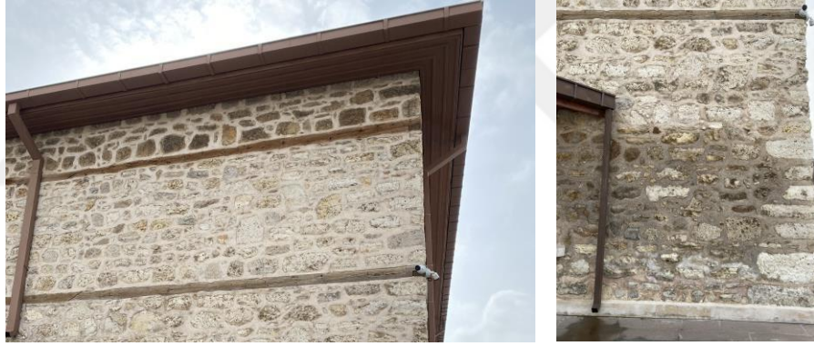
Şekil 4.43. ve Şekil 4.44. Kuzey duvarında yer alan ahşaplardaki soyulma ve liflenmeler ve cephe kirliliği
