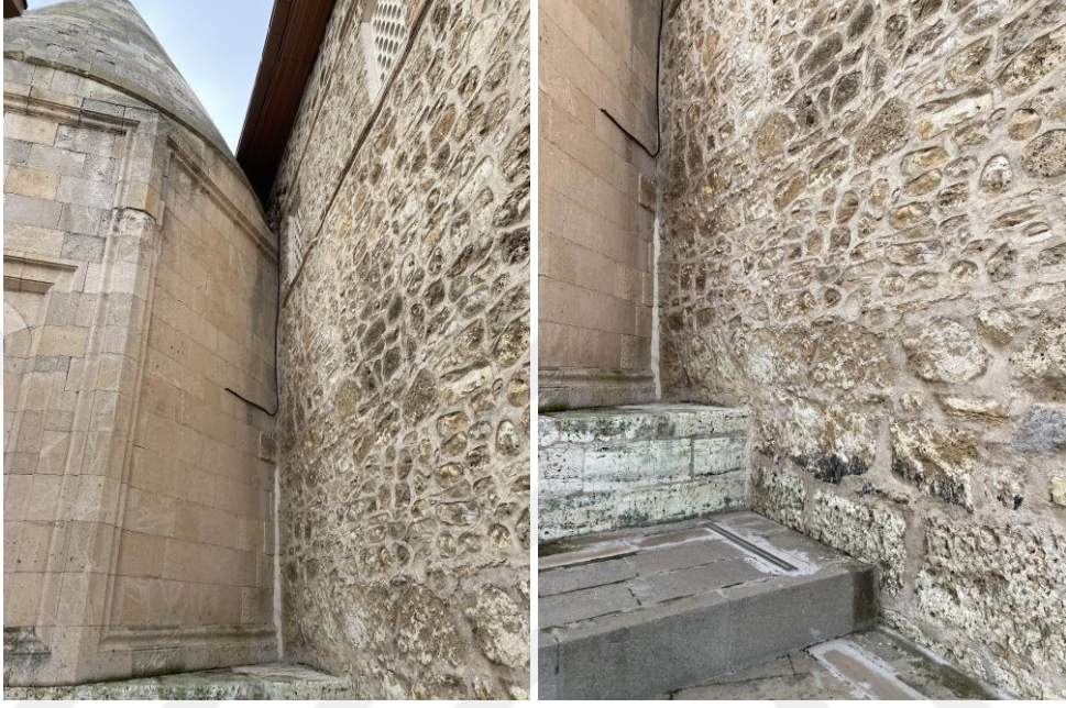
řekil 4.30. ve řekil 4.31. Eşrefođlu Cami ve Eşrefođlu Süleyman Bey Türbesi birleřiminde görölen malzeme bozulmaları
