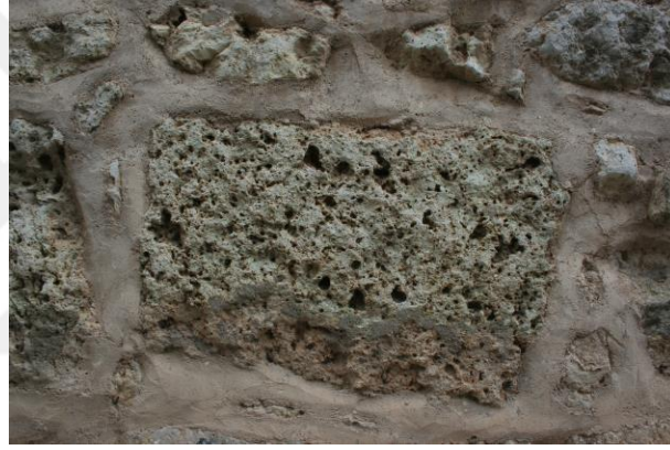
Şekil 4.40. Eşrefoğlu Cami batı cephesi taşlarında görülen yeşillenmeler
