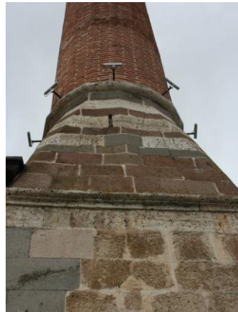
Şekil 4.28. Eşrefoğlu Camii minare kaidesi
