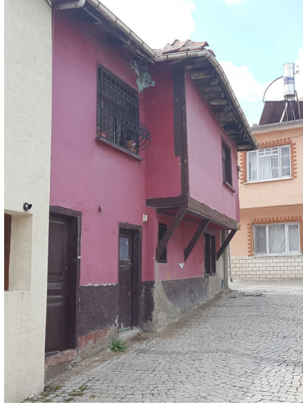
Şekil 2.23. Ahşap pencere ve kapılar, ahşap silmeler
