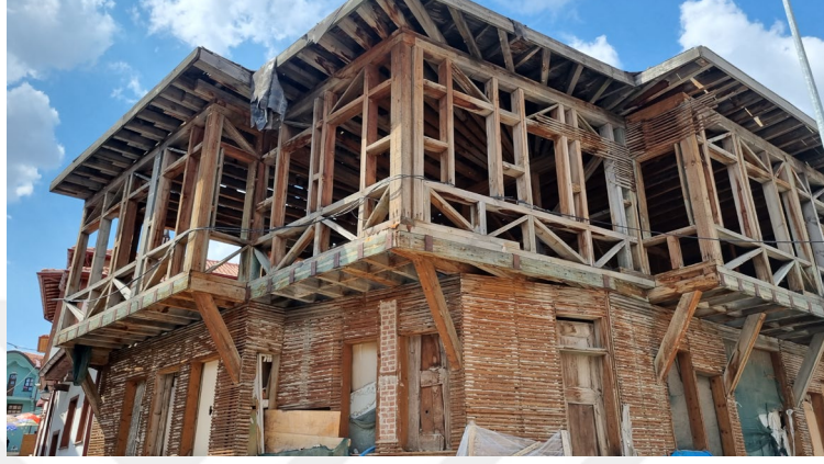
Şekil 2.27. Odunpazarı evleri ahşap iskelet
