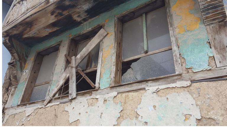
Şekil 2.29. Ahşap karkas arası kerpiç malzeme
