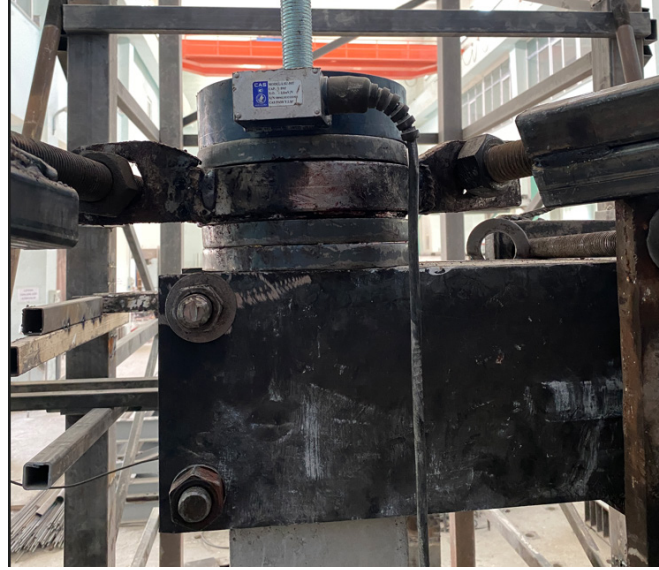
Şekil 3.26 Döner mafsali sisteminin kolon üzerine yerleştirilmesi
