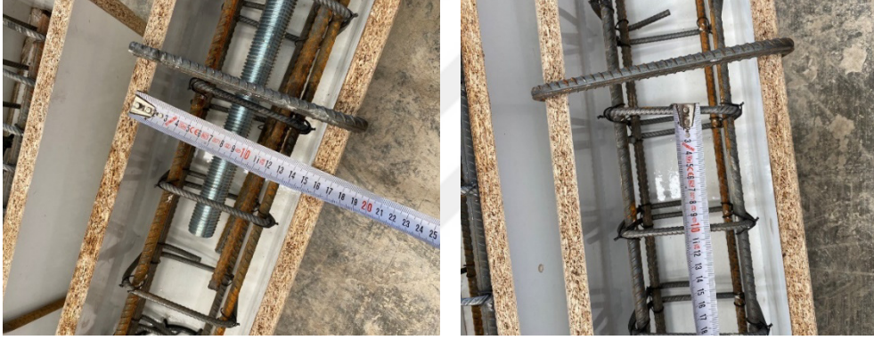
Şekil 3.12 Kalıp ve donatıların kontrolü
