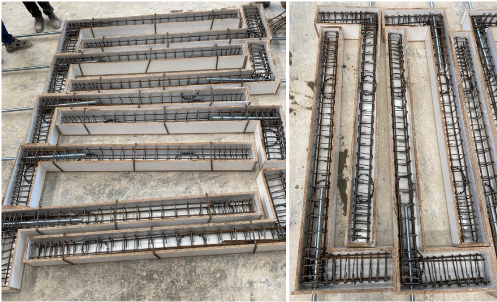
Şekil 3.13 Kalıp ve donatıların kontrolü
