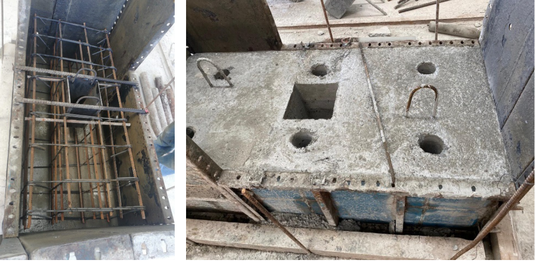
Şekil 3.19 Temel kalıbı ve temel betonunda bırakılan boşluklar
