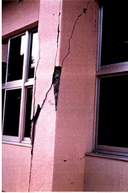
Şekil 1.20 Düzensiz yapılarda burulmanın oluşumu (Zhou ve ark., 2000)
