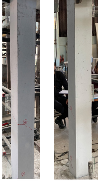
Şekil 4.65 SN-5 numunesinde meydana gelen ilk çatlaklar
