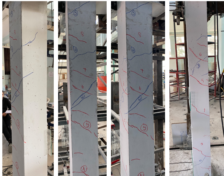
Şekil 4.66 SN-5 numunesinin burulma çatlama düzeyinde hasar durumu
