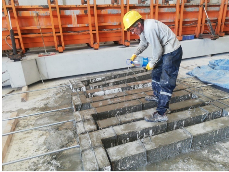
Şekil 3.18 Beton dökümü yapılan numunelerin kür işlemi
