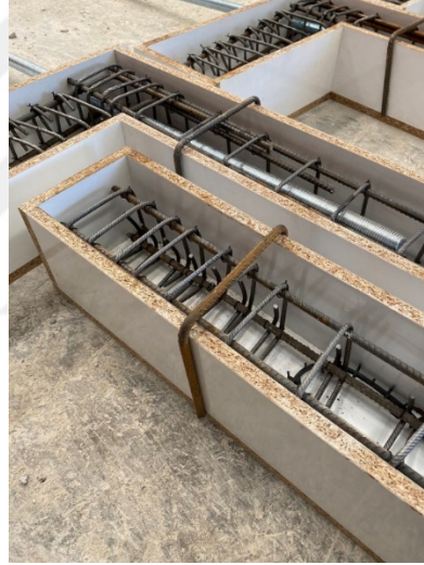
Şekil 3.15 Kalıpların sabitlenmesi
