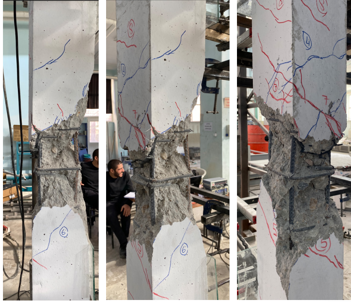
Şekil 4.68 SN-5 numunesinin nihai durumda hasar durumu
