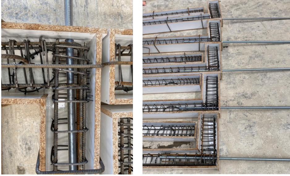
Şekil 3.14 Donatıların ve gijonun kalıplara yerleştirilmesi
