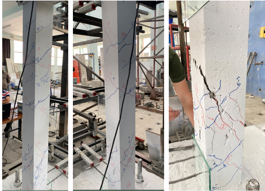
Şekil 4.3 SN-0 numunesinin burulma çatlama düzeyinde hasar durumu
