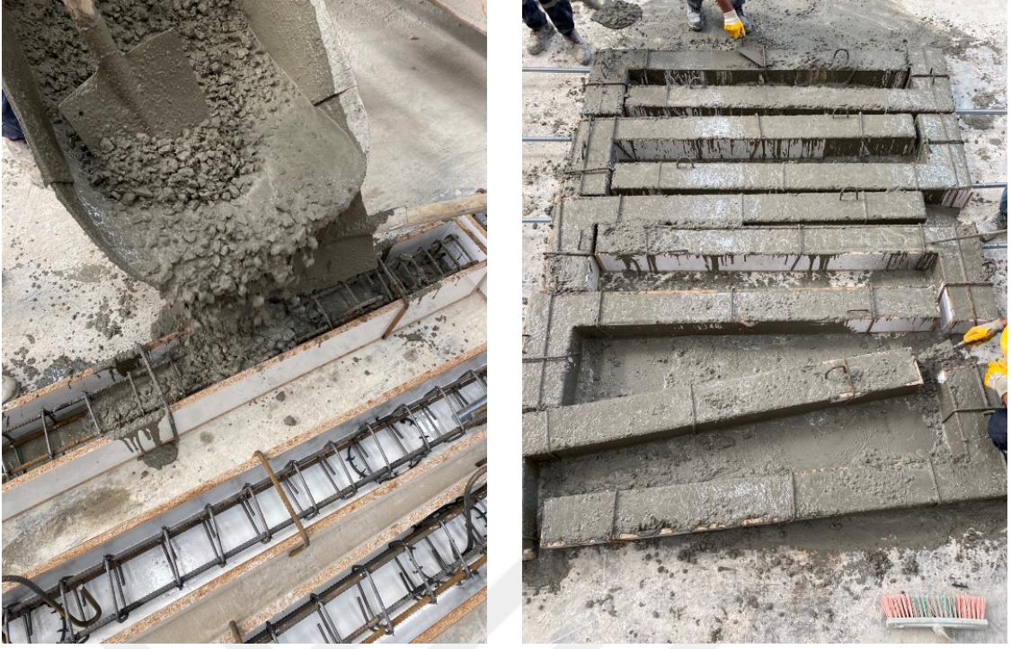
Şekil 3.16 Beton dökümü
