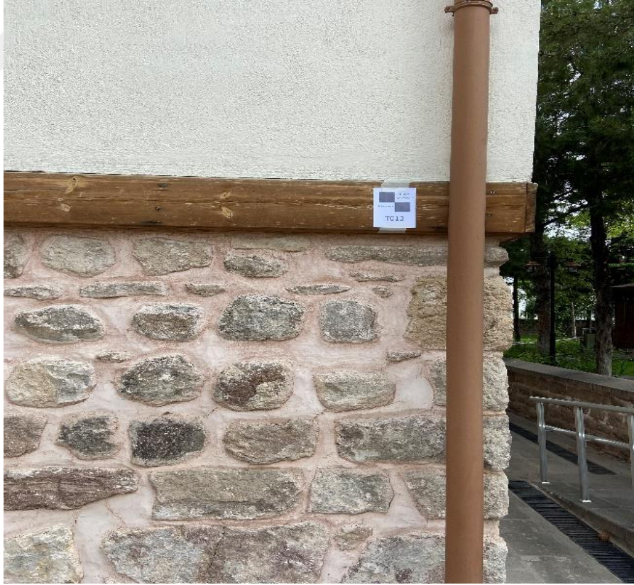
Şekil 3.43. Hoca Ahmet Fakih Camii tarama öncesi yerleştirilen kâğıt hedef işaretlerini gösterir fotoğraf.
