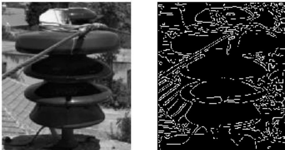
Şekil 0.9. Canny kenar belirleme yöntemi uygulanmış izolator (Aslan, Y. ve ark., 2020)
